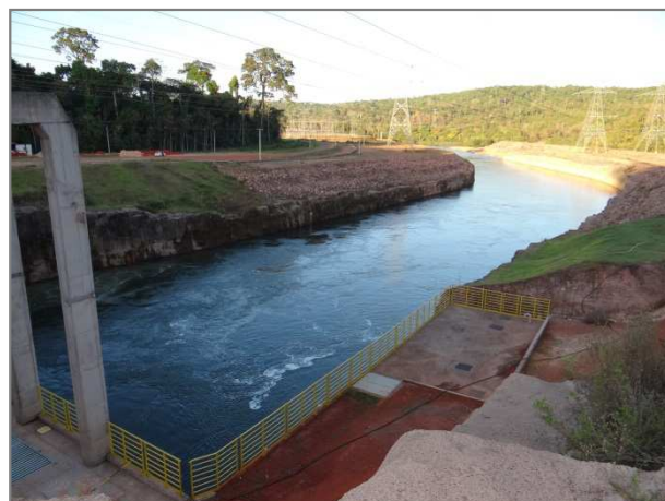
Figura 15. Registro fotográfico do Ponto 8 – Canal de Fuga. Fonte: Biota Projetos e Consultoria Ambiental Ltda, 2012.
