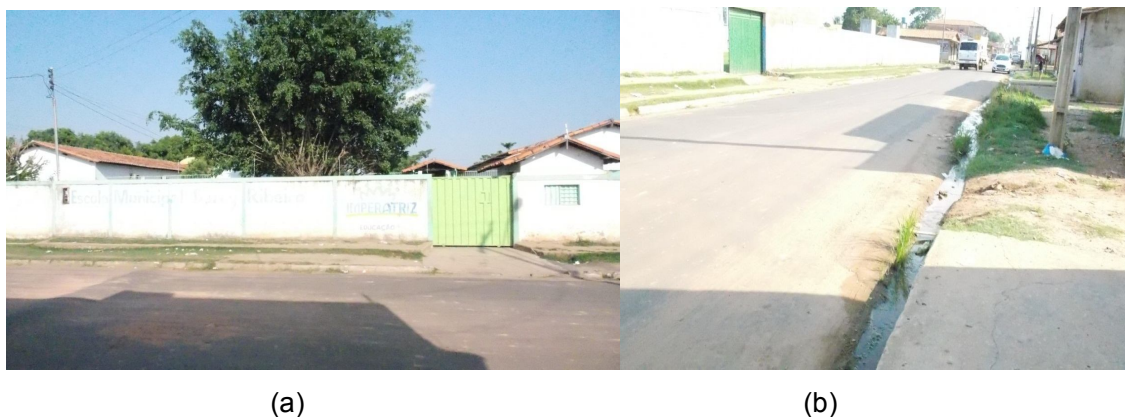
Figura 2: (a) Aspecto visual da fachada da Escola Municipal Darcy Ribeiro, (b) : Aspecto visual do entorno da Escola Municipal Darcy Ribeiro Foto: R. C. C. Lima, 2014.
