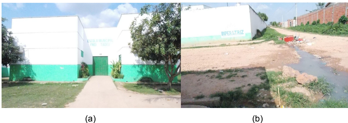
Figura 6: (a) Vista interna, (b) entorno da Escola Municipal Frei Tadeu. Foto: R. C. C. Lima, 2014.
