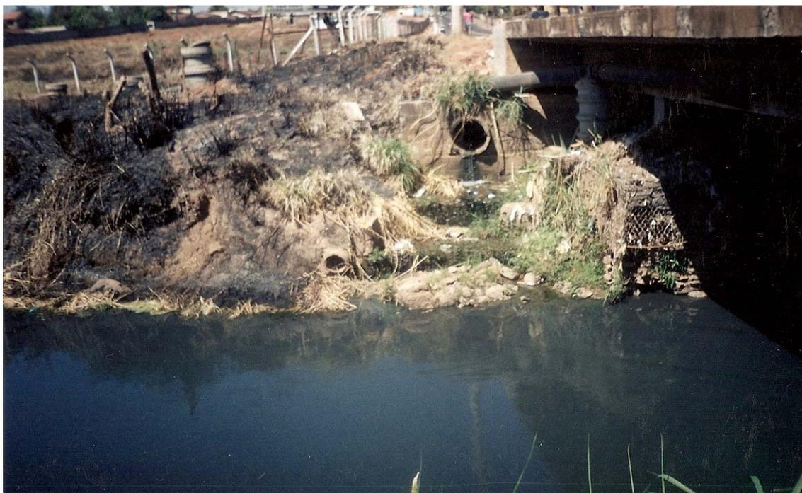
Foto 10 – Lançamento de esgoto fluvial no ribeirão Anicuns/Criméia Oeste (LM-018)
