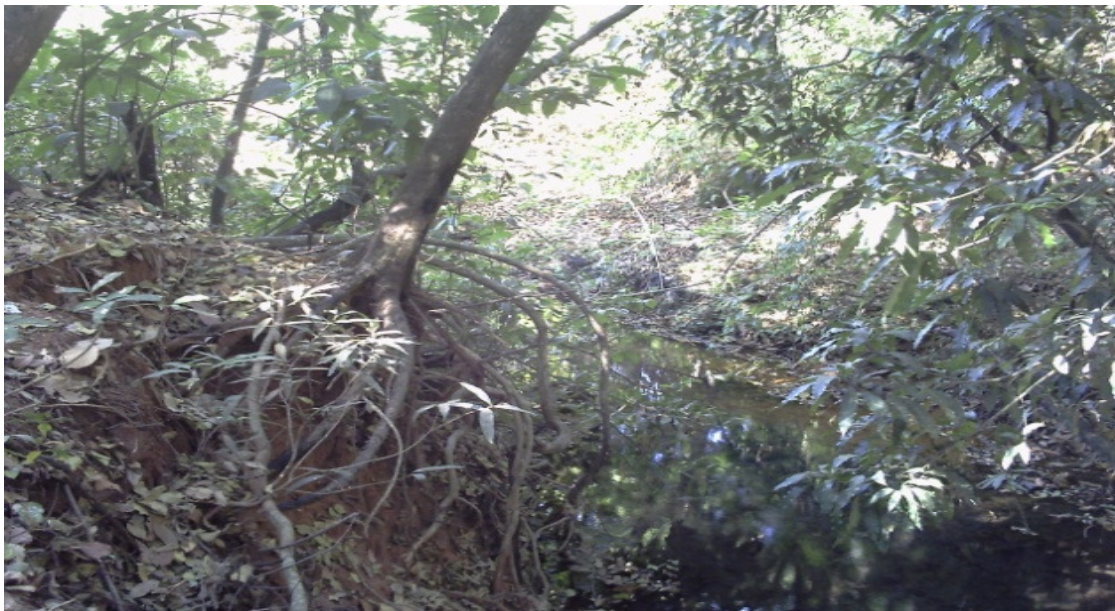
Figura 20. Parque Areião – Goiânia – GO. Aspectos de erosão fluvial nas margens do Córrego Areião.
