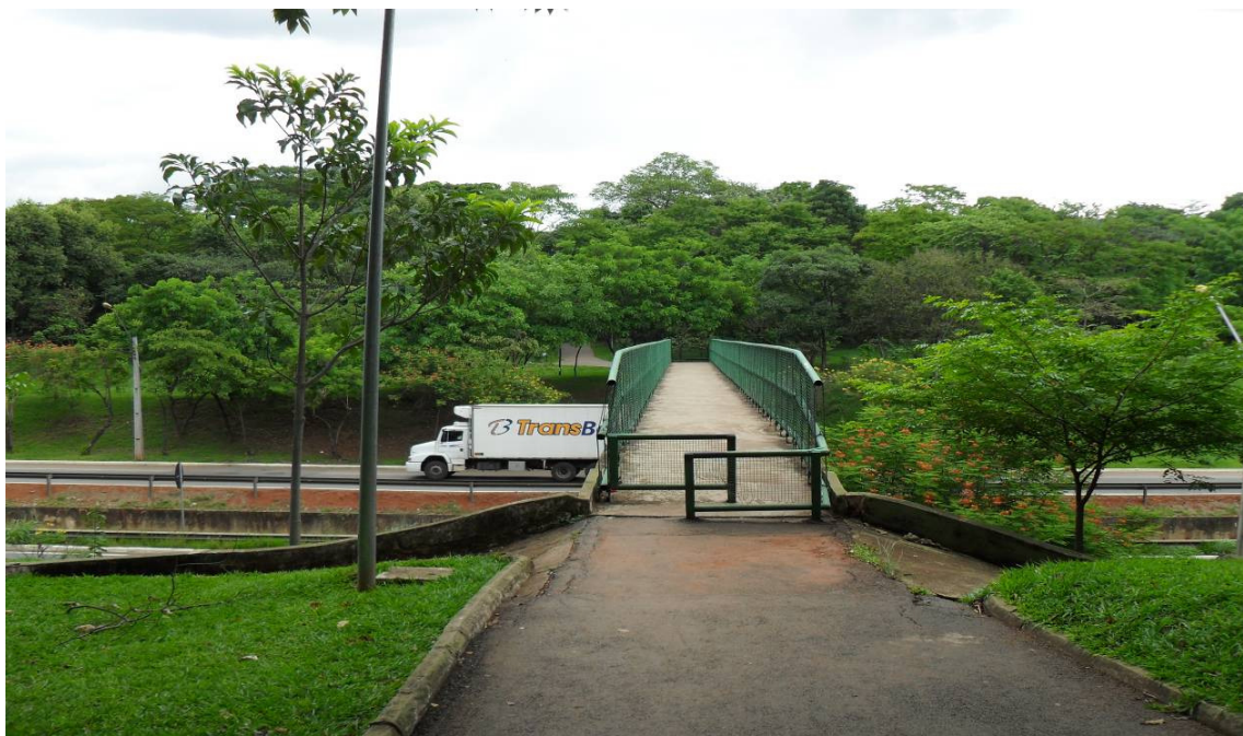
Figura 4. Aspectos do Parque Botafogo – Goiânia – GO. Ponte de ligação entre Setor Central e Vila Nova.
