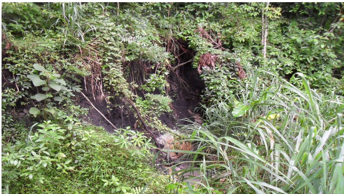
Figura 31. Jardim Botânico – Goiânia – GO. Degradação da mata ciliar do Córrego Botafogo.
