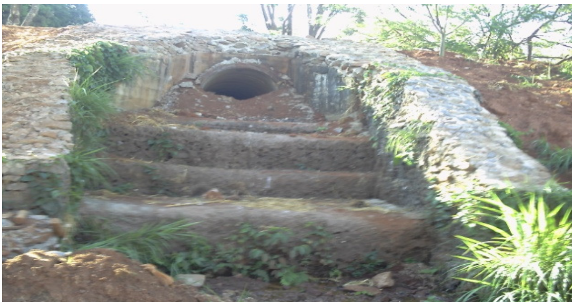
Figura 22. Parque Areião – Goiânia – GO. Aspectos de galeria pluvial 1,10m estrutura de concreto e dissipador de energia. Fonte: Cardoso, 2009.
