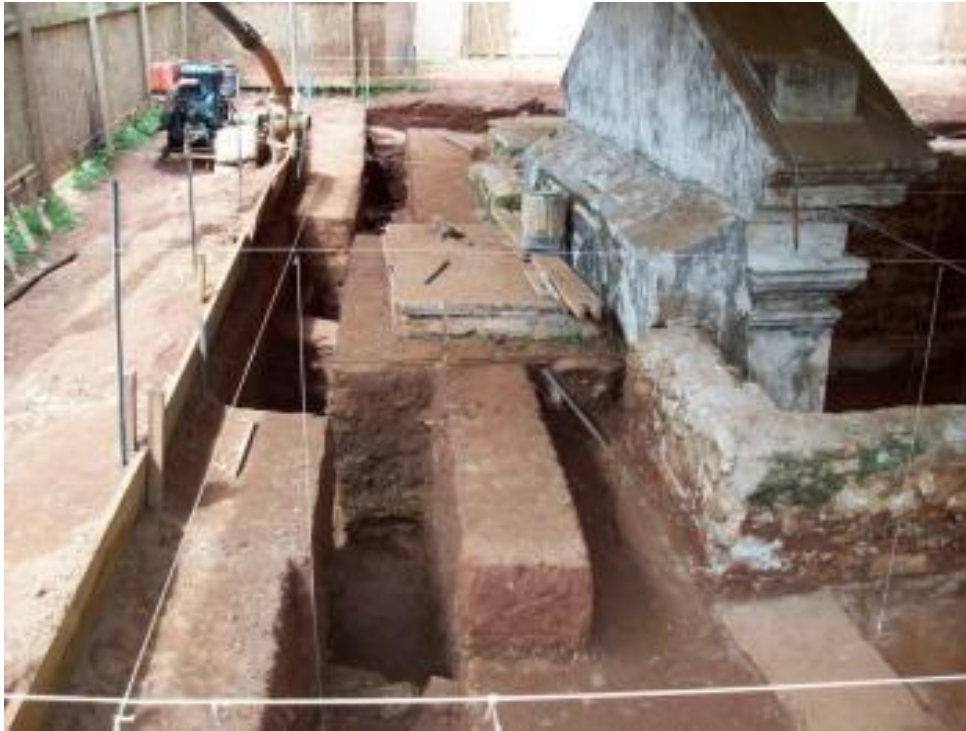
Figura 23: Escavação no fundo
