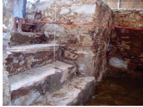
Figura 6: Detalhes da construção posterior
