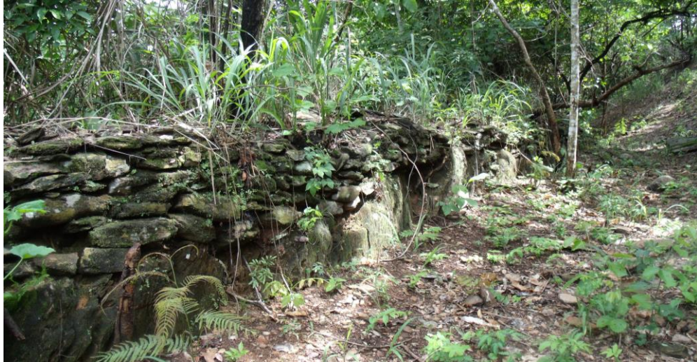
Figura 39: Estruturas da estrada do nascente. Fonte Dantas 2012
