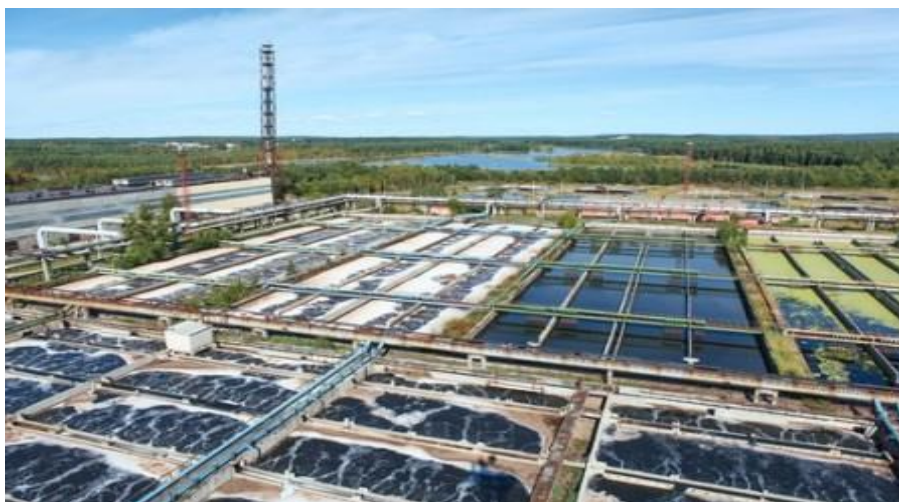
Figura 10 – Estação de Tratamento de Esgoto (ETE)
