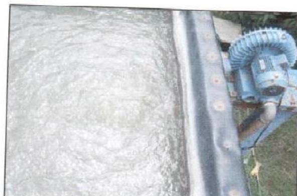
**Imagem 25: Reator Anaeróbico e Bomba de Flotação**
