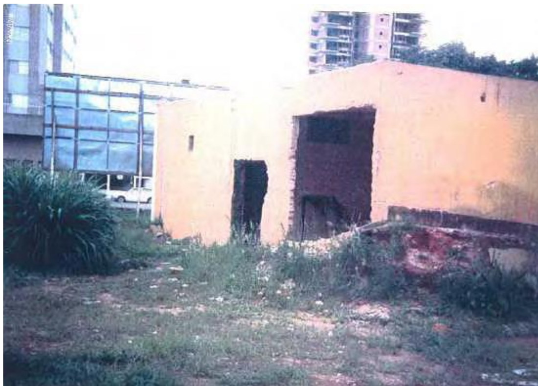
Figura 1 - Escombros do Instituto Goiano de Radioterapia. Fonte: Google imagem
