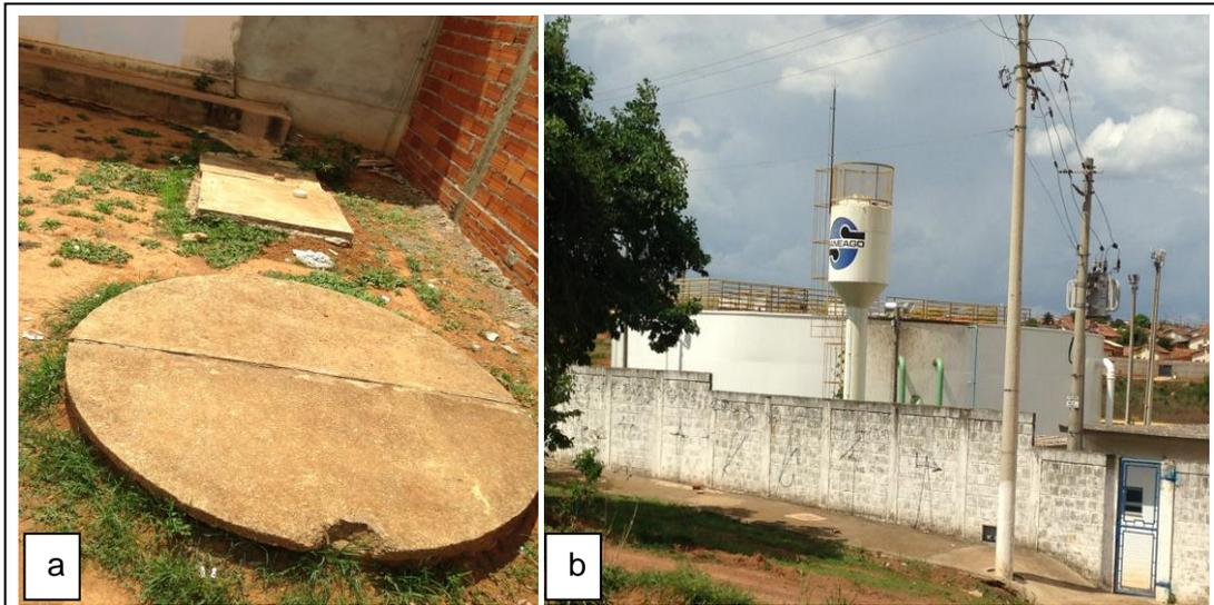
**Figura 33** – Tipos de esgotamento sanitário: a) Fossa séptica e sumidouro nos módulos I a IV e b) Estação de tratamento de esgoto para atender os módulos VI e VII.
