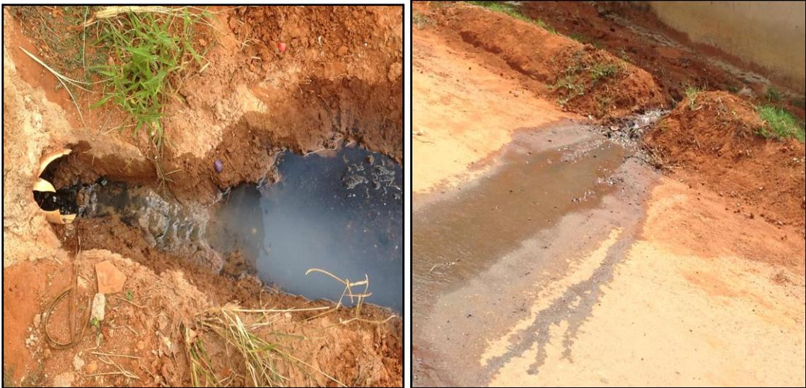
**Figura 40** – Esgoto doméstico extravasando de uma residência e escorrendo pelas vias do bairro./ Fonte: Acervo pessoal, data: 19/11/2016.
