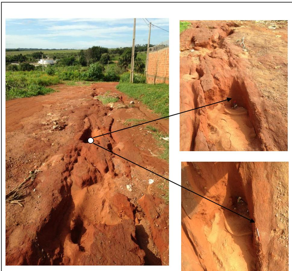
**Figura 48** - Erosões provocadas pelas águas pluviais na Avenida Rainha dos Lagos no Jardim Cerrado III.
