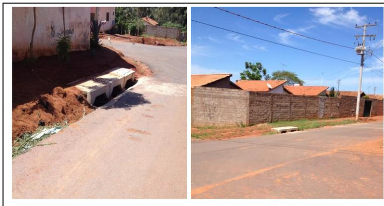
**Figura 51** – Bocas de lobo construídas no mês de dezembro de 2016 no Jardim Cerrado III de forma irregular.
