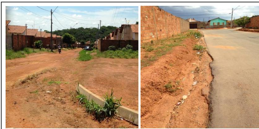
**Figura 49** – Inexistência de infraestrutura de drenagem de águas pluviais no Residencial Jardim do Cerrado I a IV.
