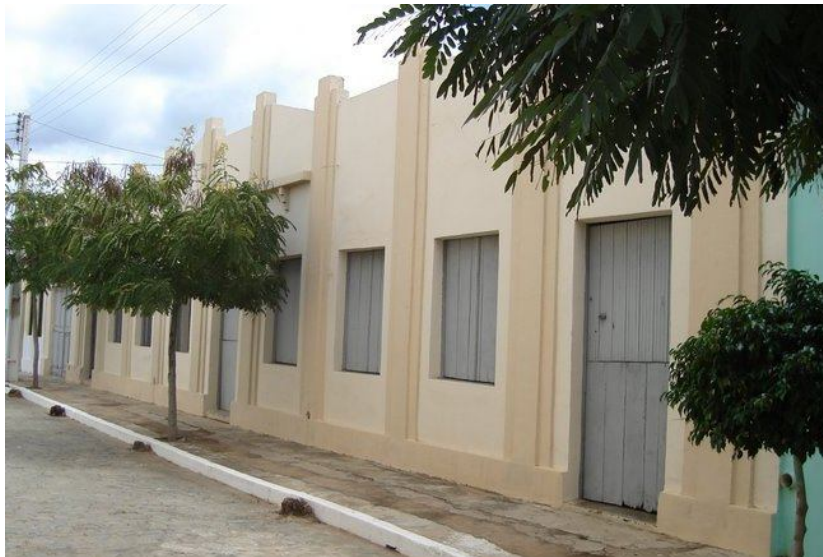
Figura 4: Prédio da antiga Casa de Caridade de Cabaceiras Fonte: acervo do Santuário Pe. Ibiapina.
