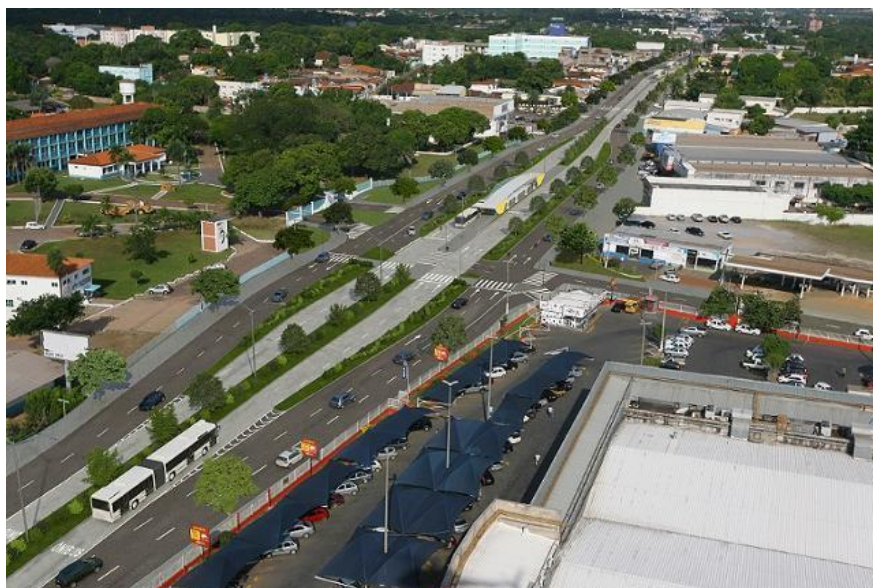
Figura 21 - Adequação viária na Avenida Fernando Correa da Costa. Fonte: AGECOPA, MT.
