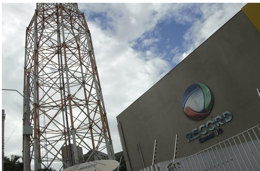
Figura 38 - Central de Televisão da Rede Record. Fonte: Autora, 2016.
