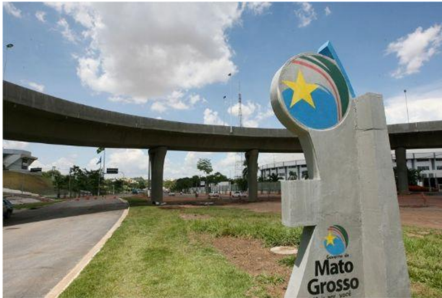
Figura 26 - Viaduto da Avenida Historiador Rubens de Mendonça próximo ao Shopping Pantanal. Fonte: olhardireto.com, 2014.
