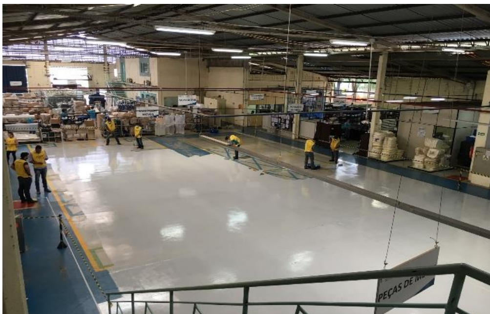
Figura 29 - Implantação do novo layout – pintura do piso
