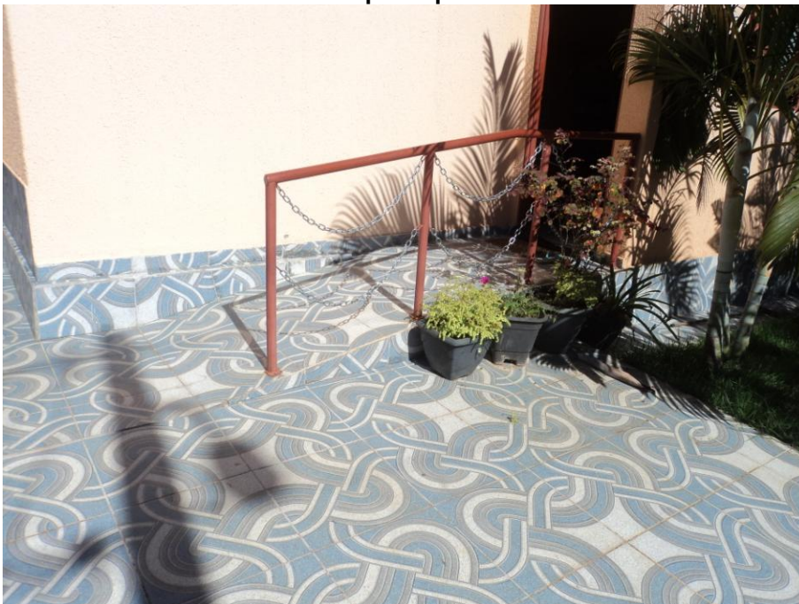
FOTO 7 - Entrada da frente - adaptada para idosos - Condomínio Harmonia.
