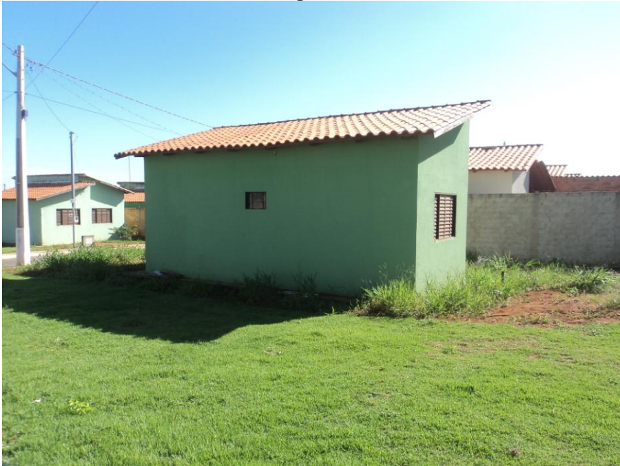
FOTO 16 - Casa sem morador, original fundos - Cond. Jardim Botânico I.
