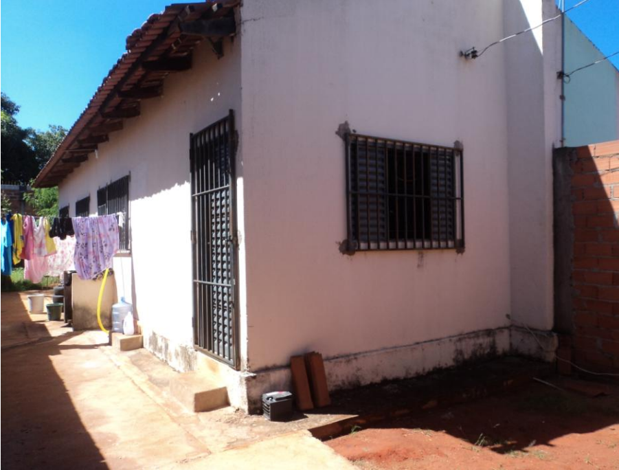
FOTO 2 - Casa alterada, grades e cimento na porta – Eldorado Oeste IV.
