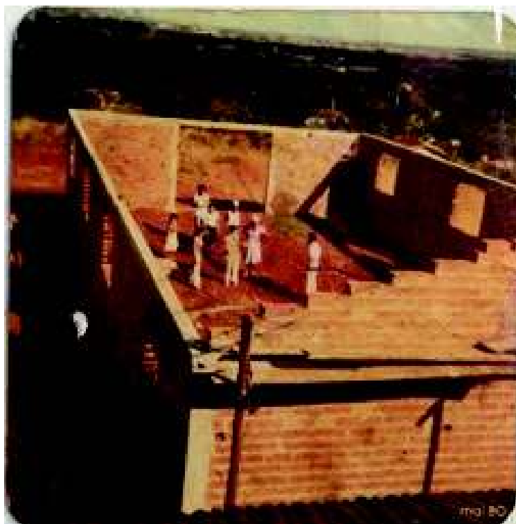
Figura 56: Igreja em construção Nota: foto do acervo de Divina Alves.
