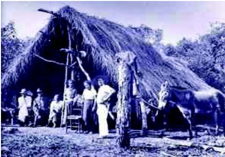
Choupana que servia de abrigo aos operários. Fonte: Acervo particular MIS (2006).
