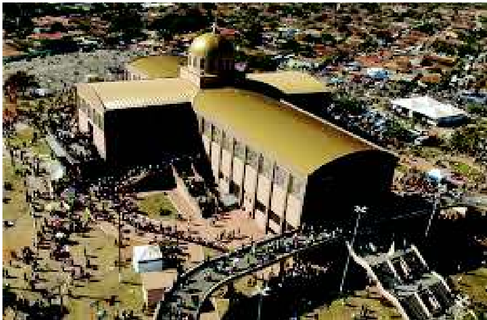
Imagem 4 - Foto da Basílica de Trindade depois da reforma.
