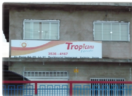
Figura 72 – Habitação ampliada para instalação de sorveteria
