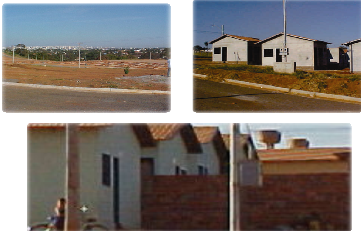
Figura 27 – Residencial Itamaracá –alicerces, casas em construção, ruas asfaltadas
