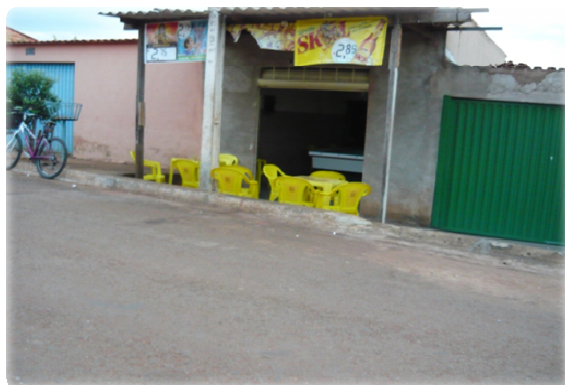
Figura 71 – Habitação ampliada para instalação de minimercado
