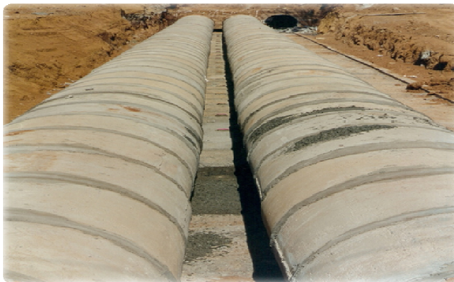
Figura 23 – Galeria de águas pluviais
