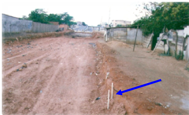
Figura 24 – Demarcação para asfalto
