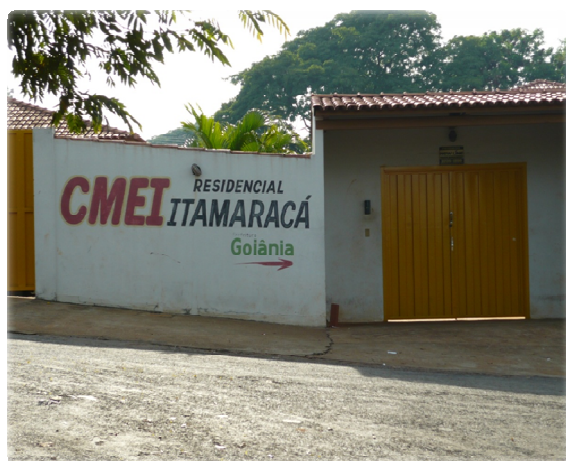
Figura 40 – Centro Municipal de Educação Infantil (Cemei) no Residencial Itamaracá (fachada)
