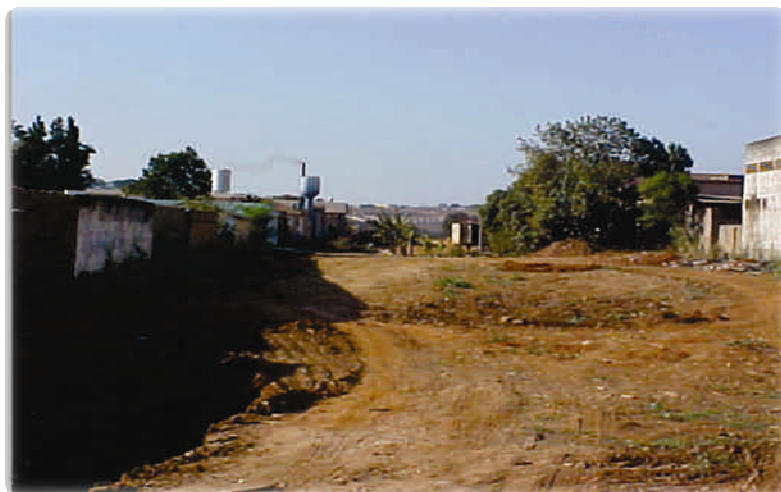
Figura 19 – Residências às margens do leito da antiga estrada de ferro em Goiânia Fonte: fotos do banner apresentado no XI Simpósio Luso-Brasileiro de Engenharia Sanitária e Ambiental (Silubesa) em (2004).
