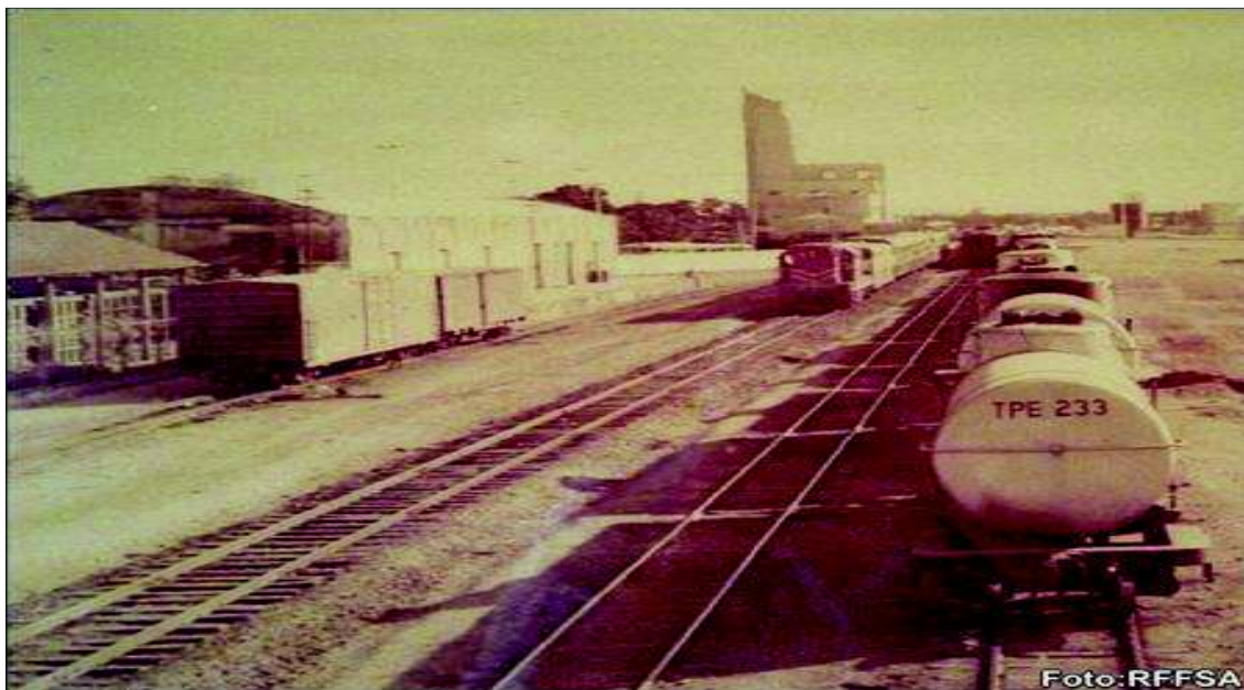
Figura 8 - Imagem da Estação Ferroviária de Goiânia e armazéns próximos. Fonte: IBGE, 2017 2
