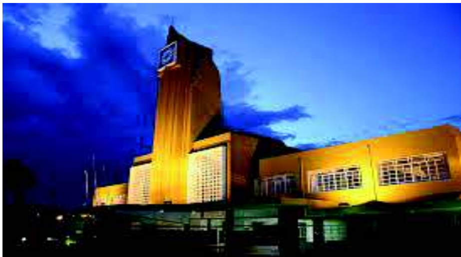
Figura 9 – Prédio da antiga Estação Ferroviária de Goiânia. Fonte: Google Imagens 3
