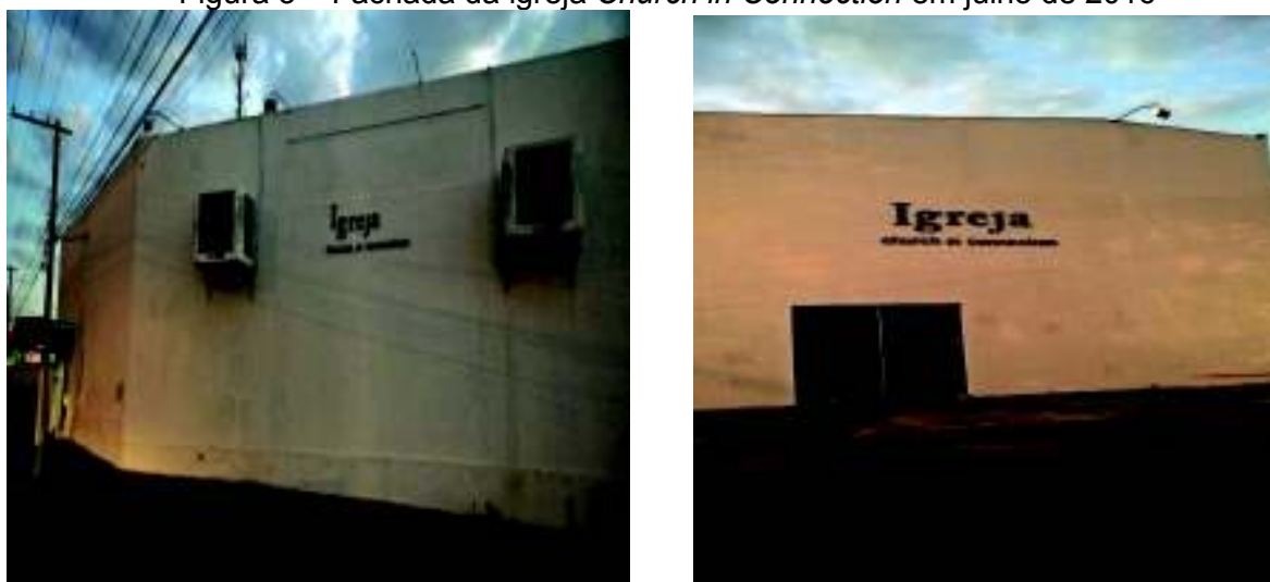
Figura 3 – Fachada da igreja Church in Connection em julho de 2016
