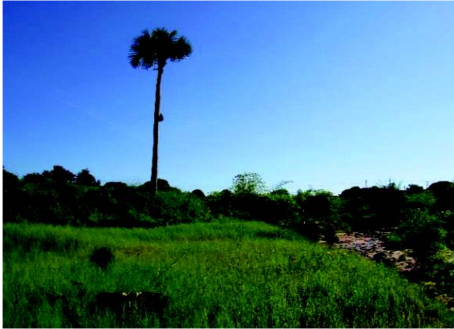
Figura 12: Situação do P-2 em 18-05-2016. Assoreamento Com presença de vegetação nativa. Fonte: Luana Barbosa (2016).
