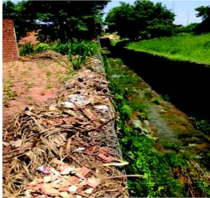
Figura 20: Situação do P-6. Canalização do córrego Cará /Afluente do córrego Baixa Funda Fonte: Luana Barbosa (2017).
