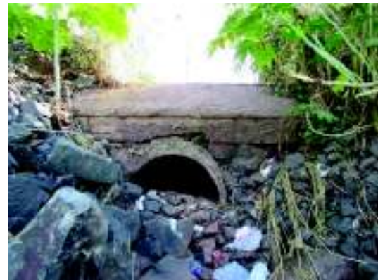
Foto 6: Situação das bocas de lobo em 24-03-16.
