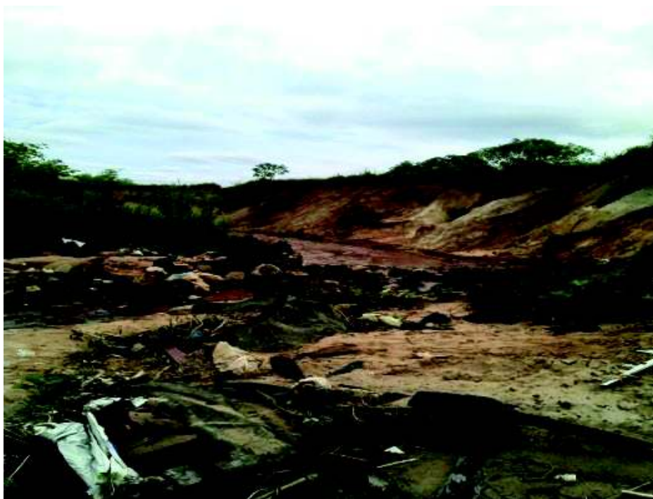
Figura 8: Situação do P-1 no período chuvoso. Presença de Assoreamento e Taludes em desmoronamento Fonte: Luana Barbosa (2017).
