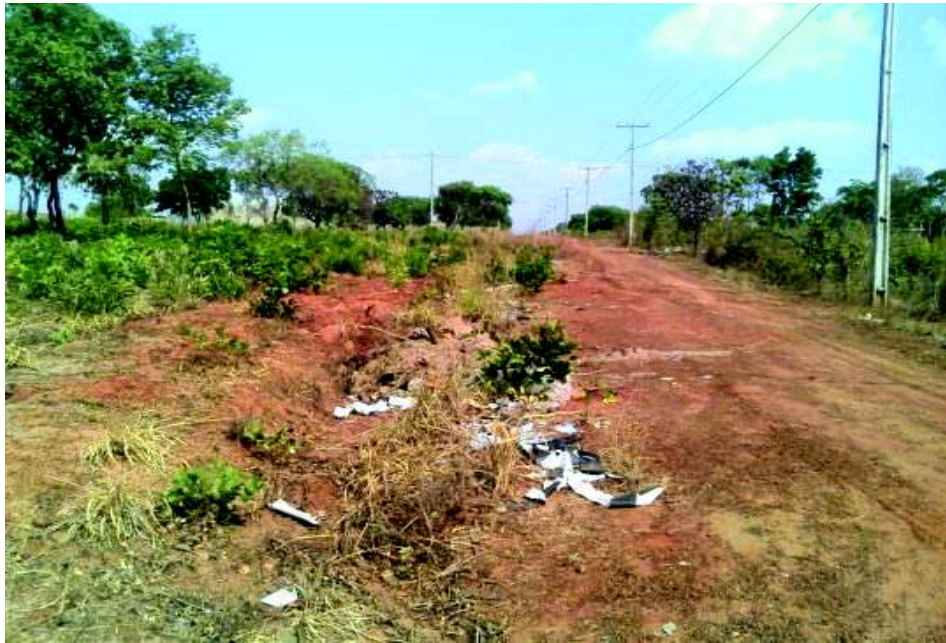
Figura 15: Situação do P-3. Presença de depósitos tecnogênicos e ausência de drenagem urbana Fonte: Luana Barbosa (2017).
