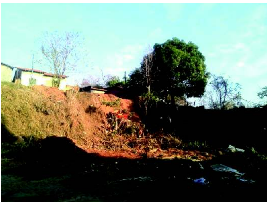
Figura 23: Situação do P-7, margem esquerda do córrego Baixa Funda, período de estiagem. Disposição irregular de resíduos as margens do córrego. Fonte: Luana Barbosa (2017).
