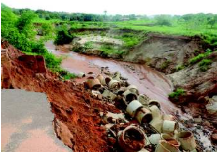
Figura 3 - Erosão sobre a Avenida Filadélfia. Fonte: Seplan/2014.
