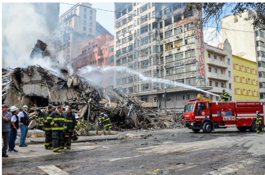
Figura 26 – Destroços do Edifício Paes de Almeida - SP
