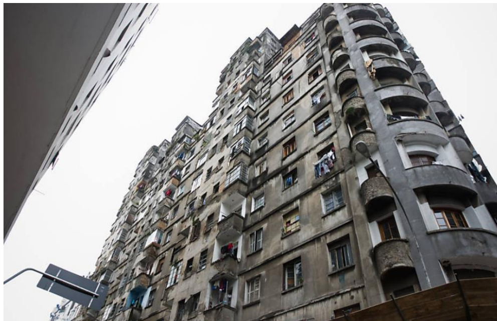
Figura 3 – Edifício Sarajevo - Cortiço localizado no bairro de Santa Efigênia Fonte: Google Imagens, 2018.
