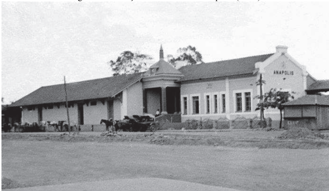
Figura 12 - Estação Ferroviária de Anápolis (1940).
