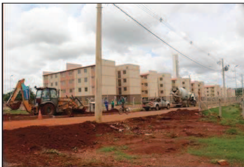
Figura 13- Máquinas trabalhando nas ruas do Conjunto Vera Cruz para concluir as obras do Residencial Nelson Mandela Fonte: Palmeri Bandeira (2018)
