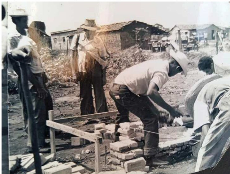
Figura 7 – Construção de casas durante a ocupação.
