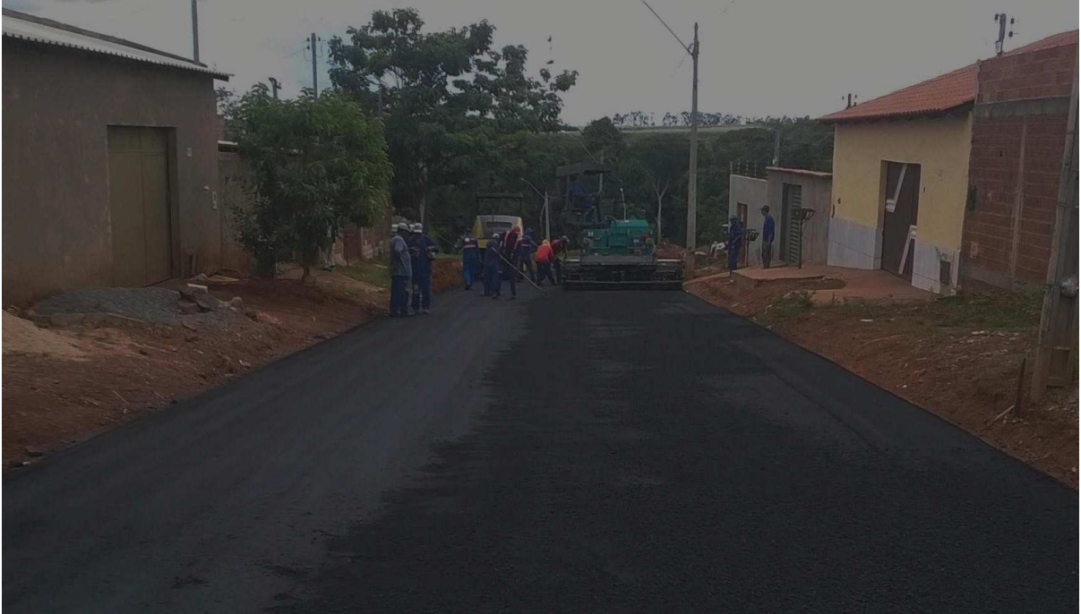
Figura 14: Pavimentação asfáltica convencional no Residencial Jardim do Cerrado III.
