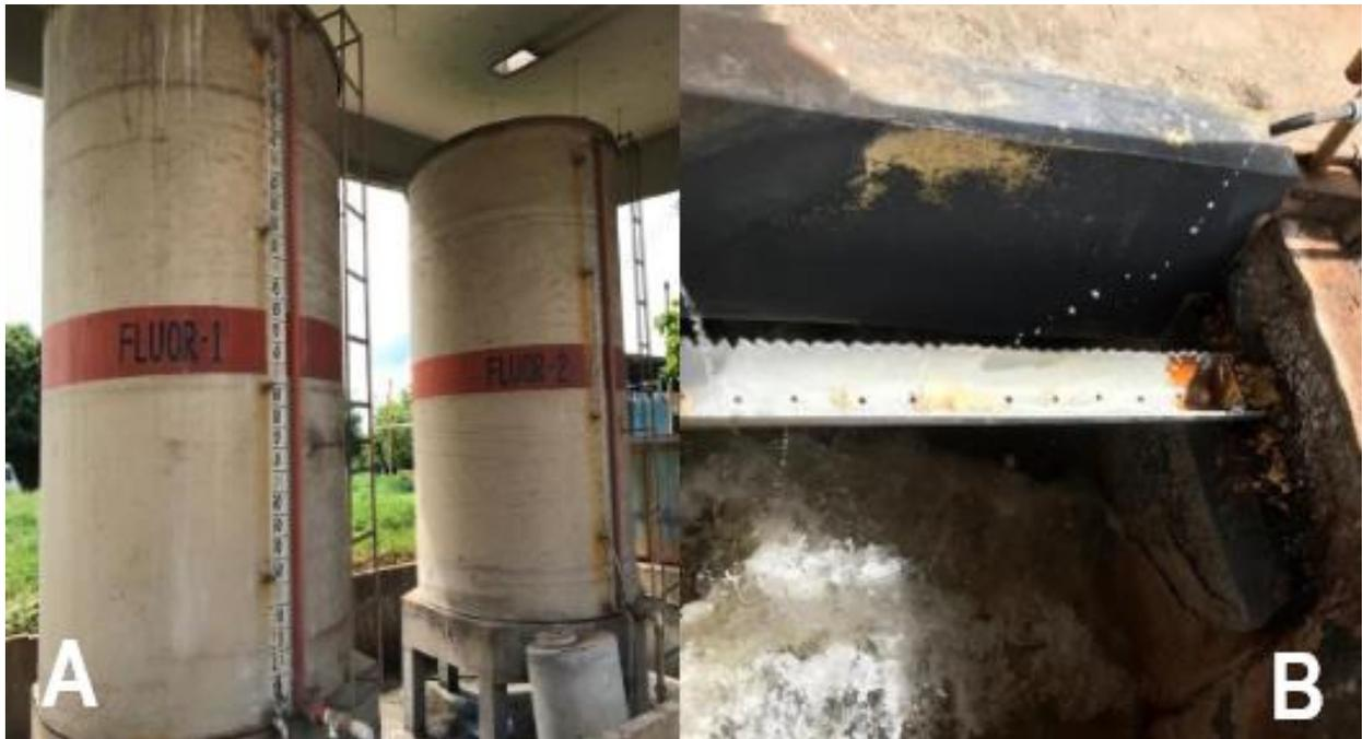
**Figura 14.** Tanque de flúor da ETA Jaime Câmara, Sistema João Leite. Foto Peterson Ferreira (2018).
