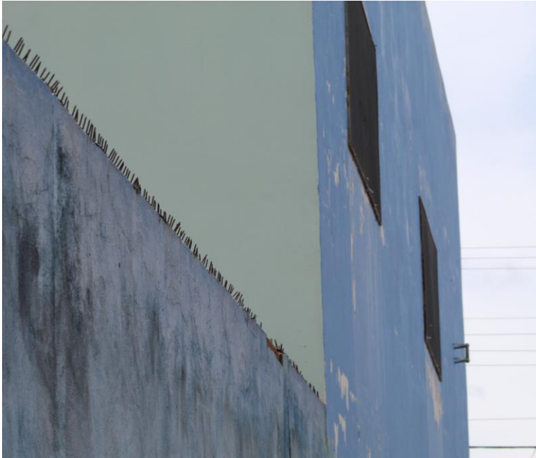
Imagem 4 – Vista externa do muro da Escola Nelson Rodrigues
