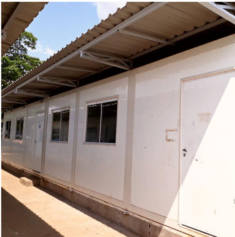
Imagem 07 – Bloco novo da Escola Maria Clara Machado
