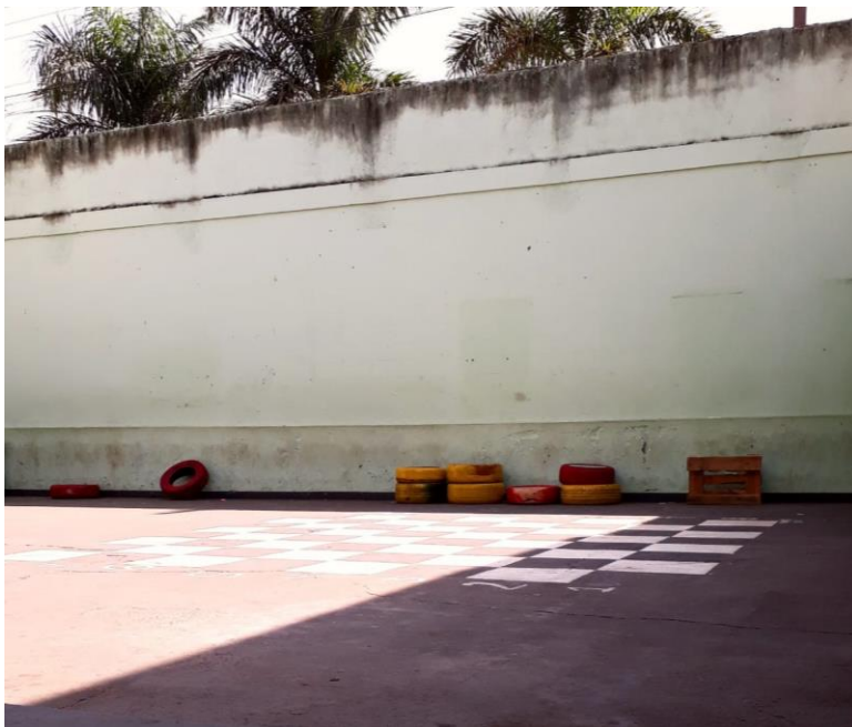
Imagem 5 – Vista interna do muro da Escola Nelson Rodrigues
