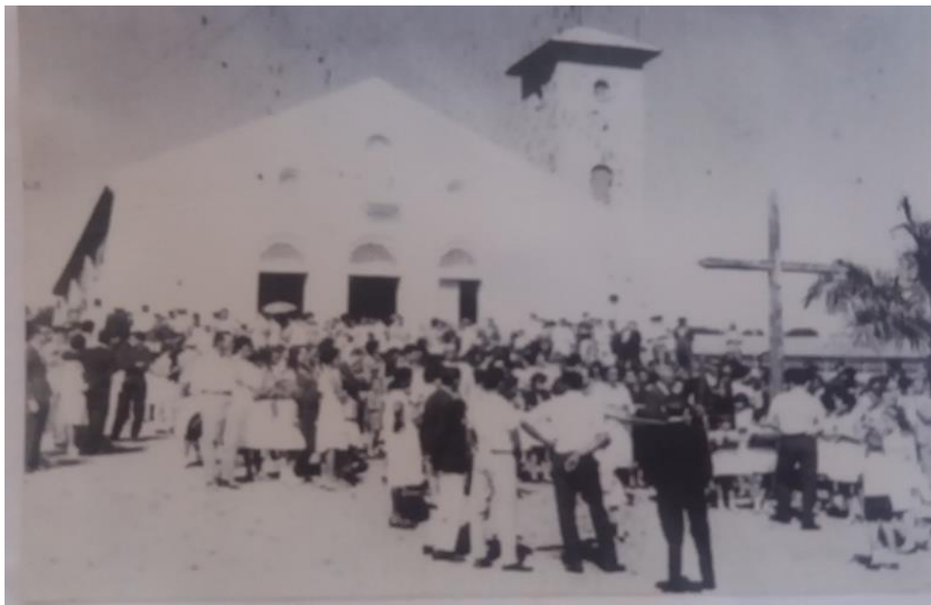
Figura 26 - Cruzeiro, em frente da antiga Igreja de Nossa Senhora de Conceição – 1940; Foto: acevo de fotos do museu de Santa Cruz.
