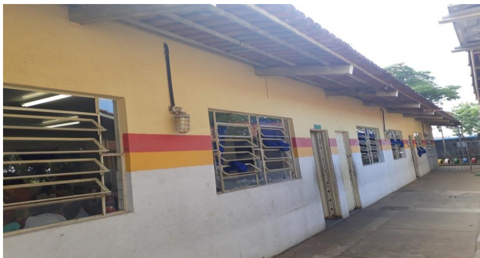
Figura 8 – Ampliação de mais um pavilhão na Escola
