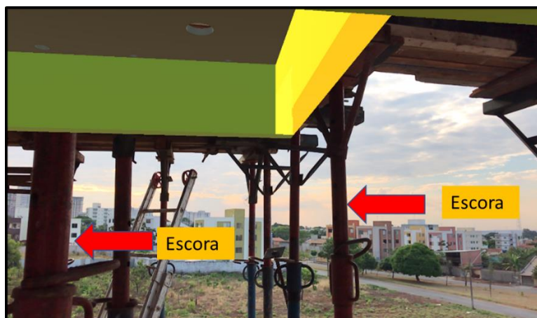
Figura 28 - Escoras na frente da visualização das vigas de bordo (indicação da seta).
