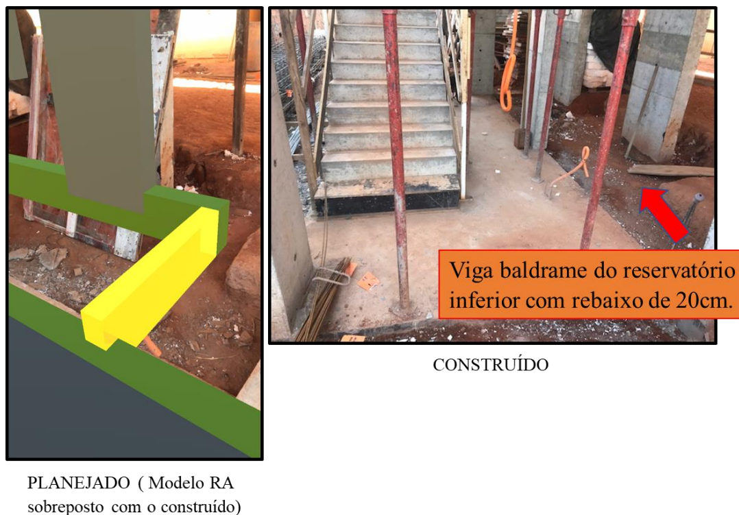
Figura 23 - Análise do modelo planejado em RA (lado esquerdo) e o construído (lado direito).
