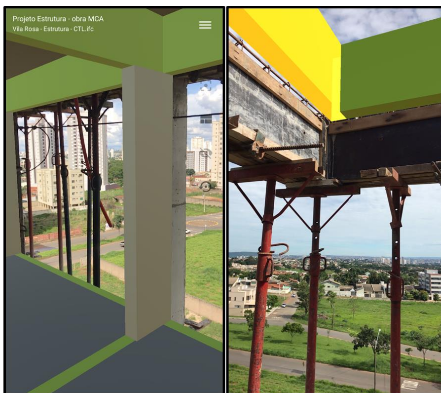
Figura 30 - Estrutura sendo construída do 5º pavimento.
