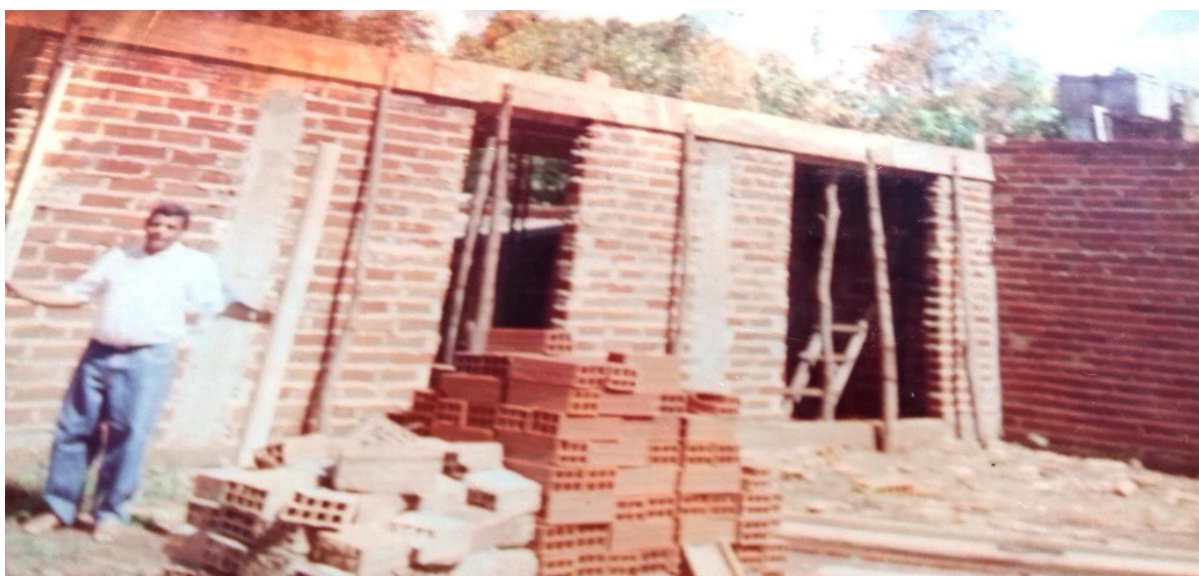
Figura 30: Obras da na sede da Federação na década de 90. Foto do arquivo da FUCEGO
