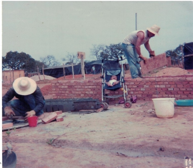
Figura 4 – Casas de lona, improviso para construção da casa própria. Fonte: Foto cedida pela moradora Ângela Maria da Silva (1990)
