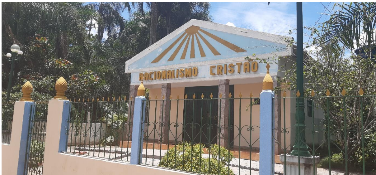
Figura 8 - Fachada da Casa Racionalista Cristã de Jesúpolis.
