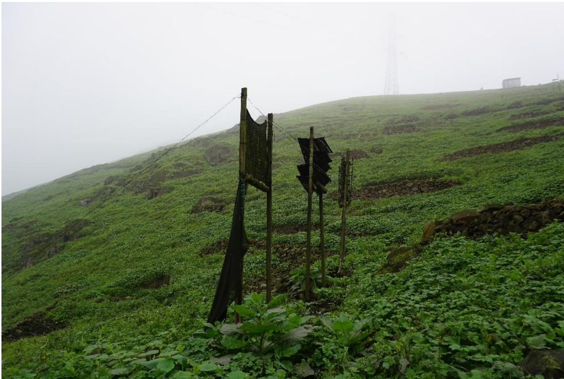
FIGURA 23 - Sistemas de captura de névoas.
