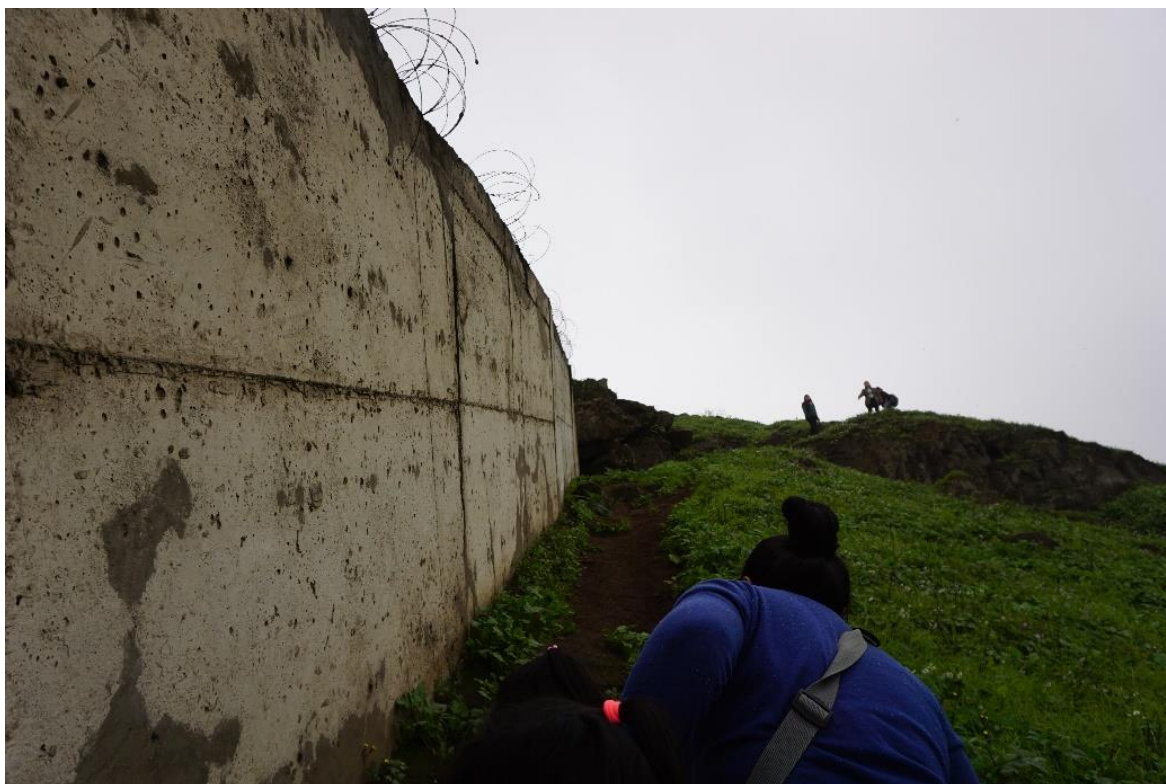
FIGURA 11 – Construção mais recente do muro.
