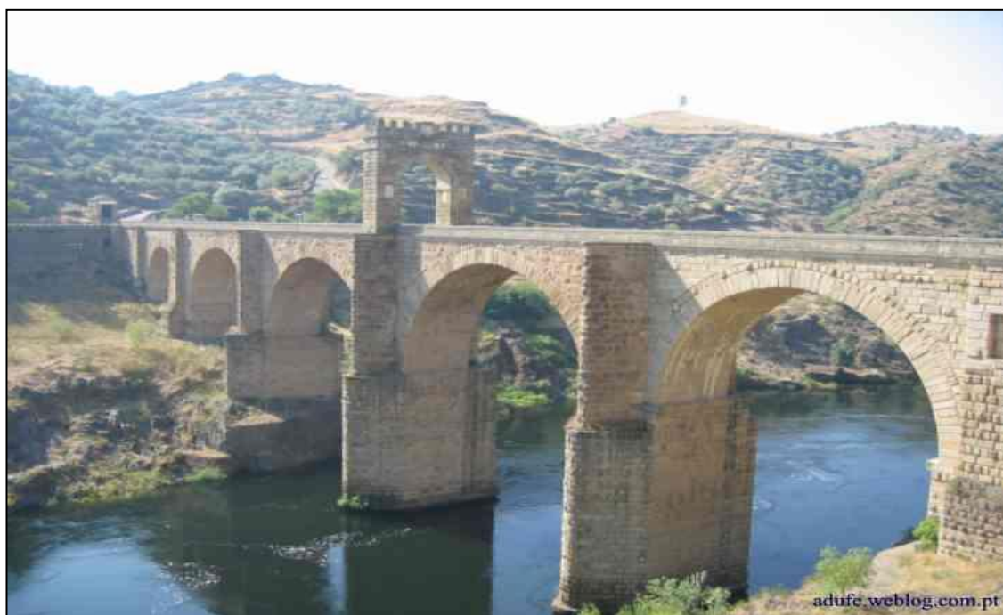
Figura 11 - Ponte de Alcántara, Espanha, extensão 194m, altura 61m e largura 8m, 106 d.C. Fonte: www.adufe.weblog.com.pt
