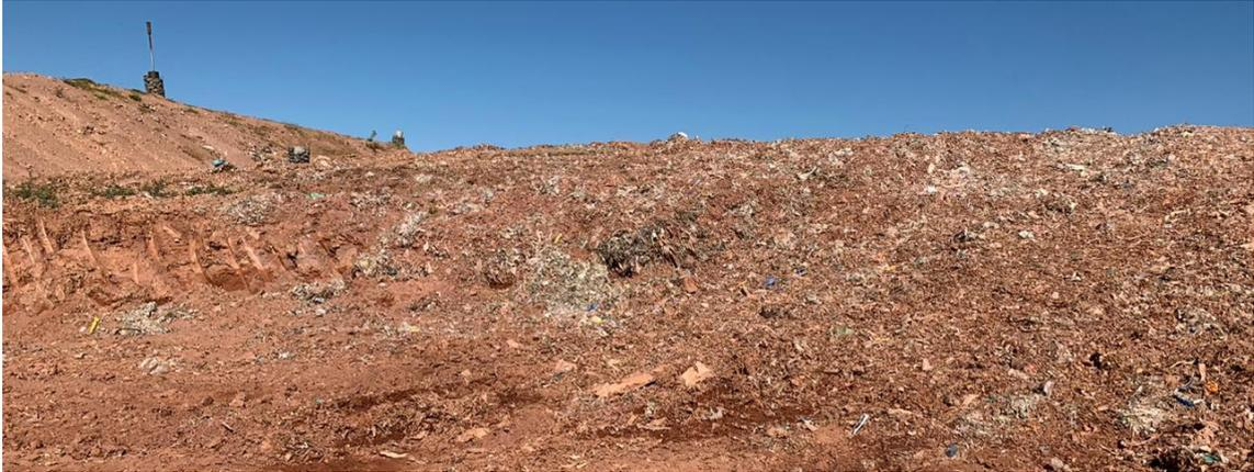
**Figura 9.** Vala para recebimento de rejeitos da empresa Jaepel no aterro sanitário de Senador Canedo – Goiás
