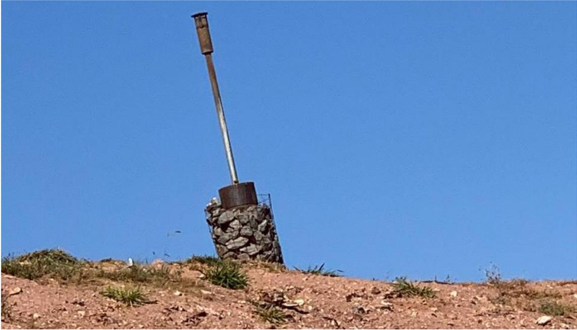
**Figura 11.** Ponto de coleta, queima e tratamento do biogás do aterro sanitário de Senador Canedo – Goiás
