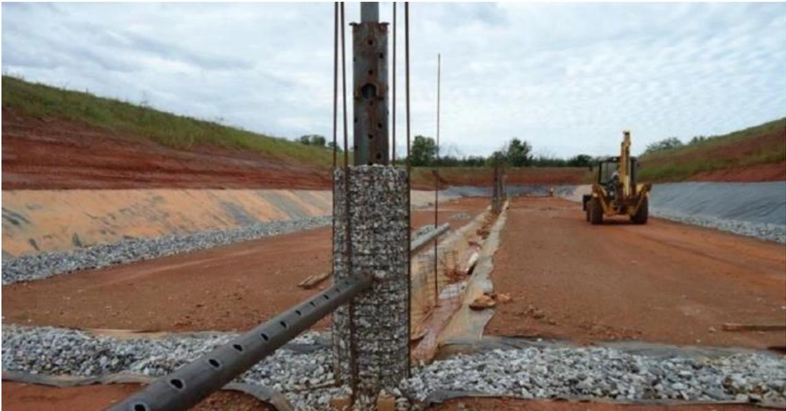
**Figura 10.** Drenos de biogás gerado em aterro sanitário vertical interligados com drenos horizontais de lixiviados
