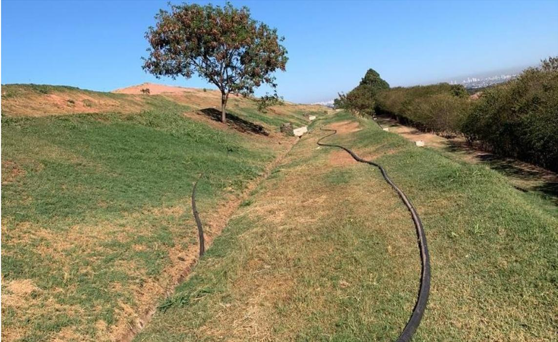
**Figura 13.** Sistema de drenagem das águas pluviais do aterro sanitário de Senador Canedo – Goiás
