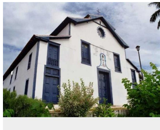
Fachada externa da Igreja Catedral de Paracatu MG. Fonte Google.
