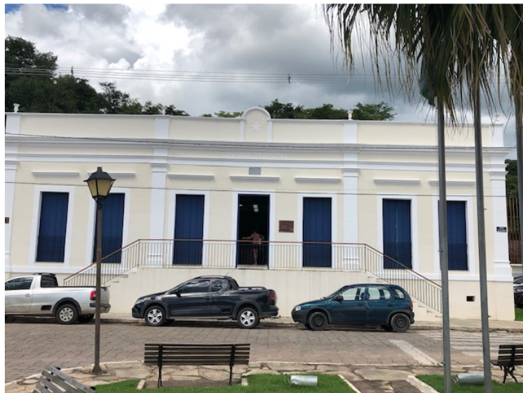
Figura 32 – Fachada restaurada da sede da Prefeitura Municipal de Goiás.
