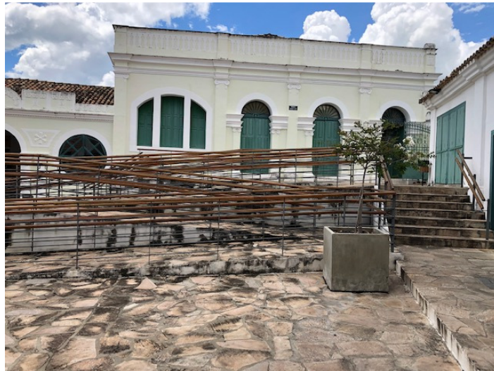
Figura 28 – Vista da escada à direita com corrimão e rampa de acesso com observância das normas de acessibilidade.
