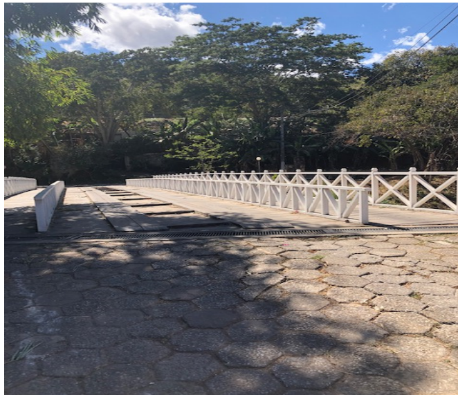
Figura 19 - Ponte Cambaúba 2. Parte superior. Laterais que permitem a passagem de pedestres e parte central reservada aos veículos.
