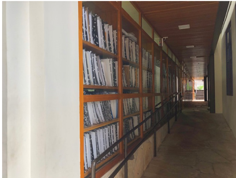
Figura 36 – Rampa interna com corrimão na sede da Prefeitura Municipal de Goiás.
