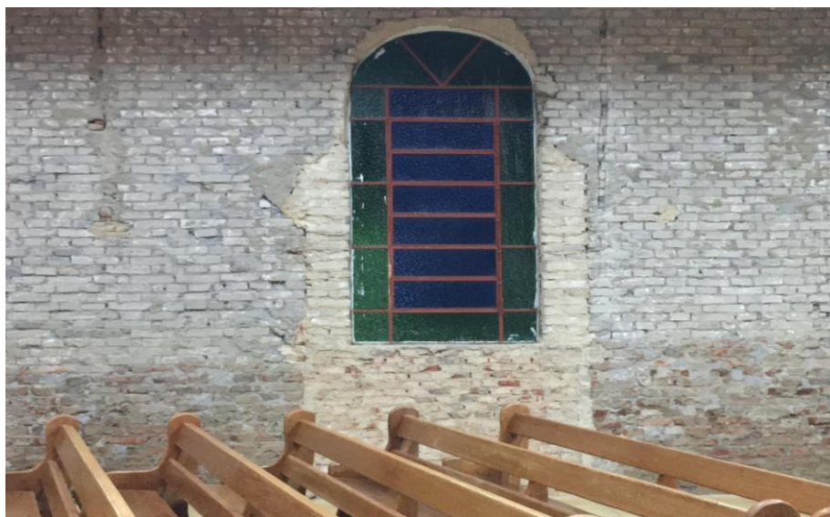
Foto 18: Interior da Igreja de São Sebastião durante a última reforma (2017)
