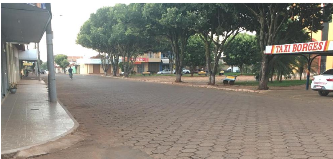
Foto 20: Pavimentação com bloquetes ao redor do largo da igreja
