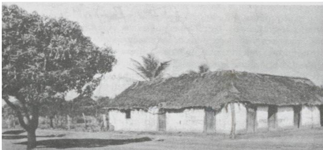
Foto 3: Casa rural goiana, coberta com telhado de palha sapê 6
