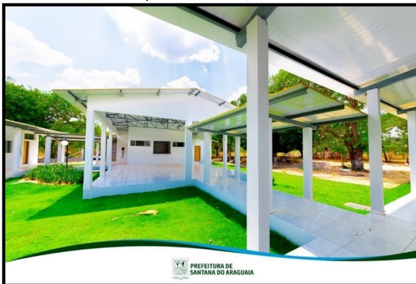
Figura 10 – Escola Professor Cupertino Contente, Distrito de Barreira dos Campos
