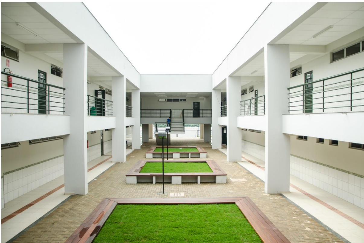
Foto 2: Blocos de salas de aula do Campus Trindade
