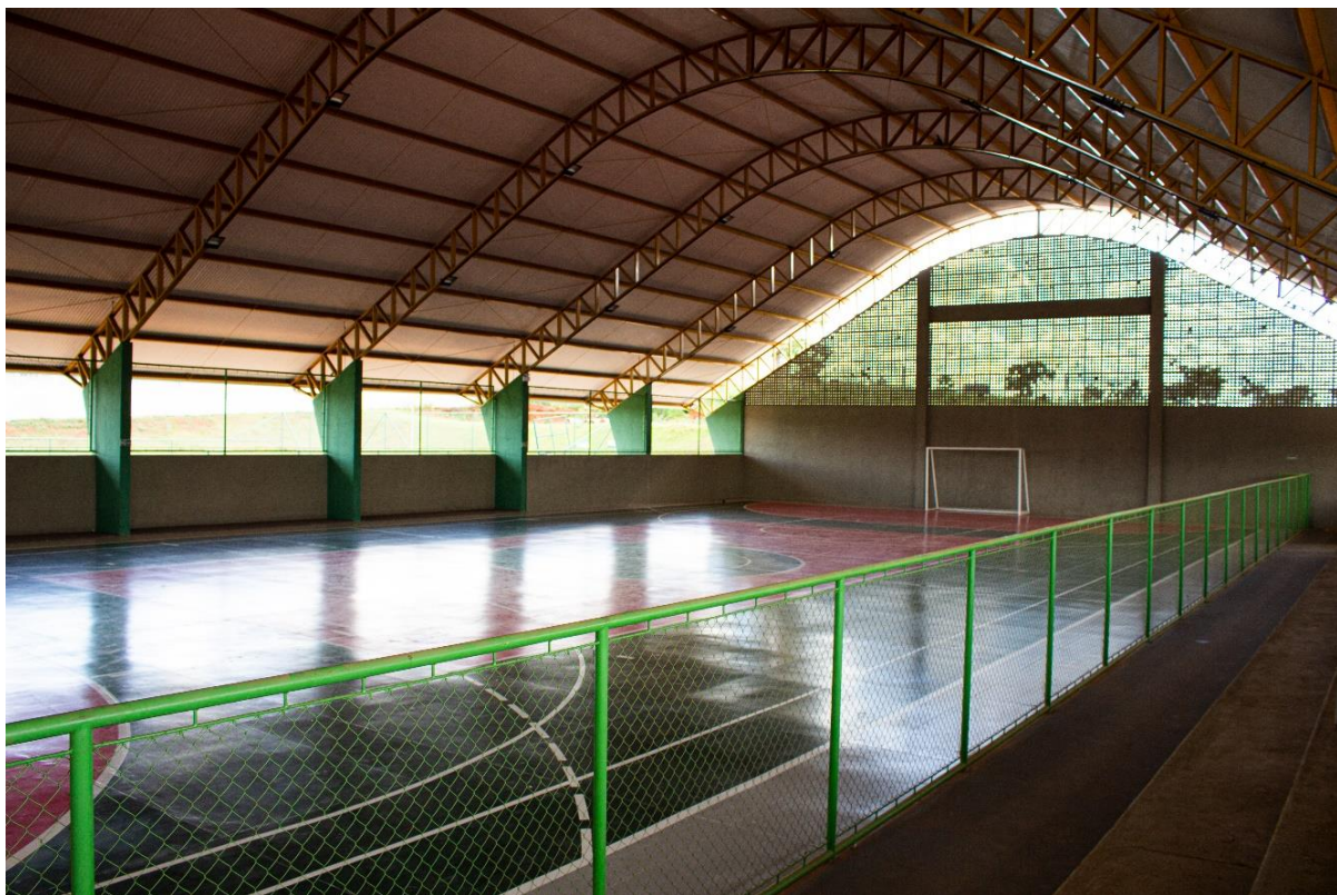
Foto 4 – Interior do Ginásio de Esportes
