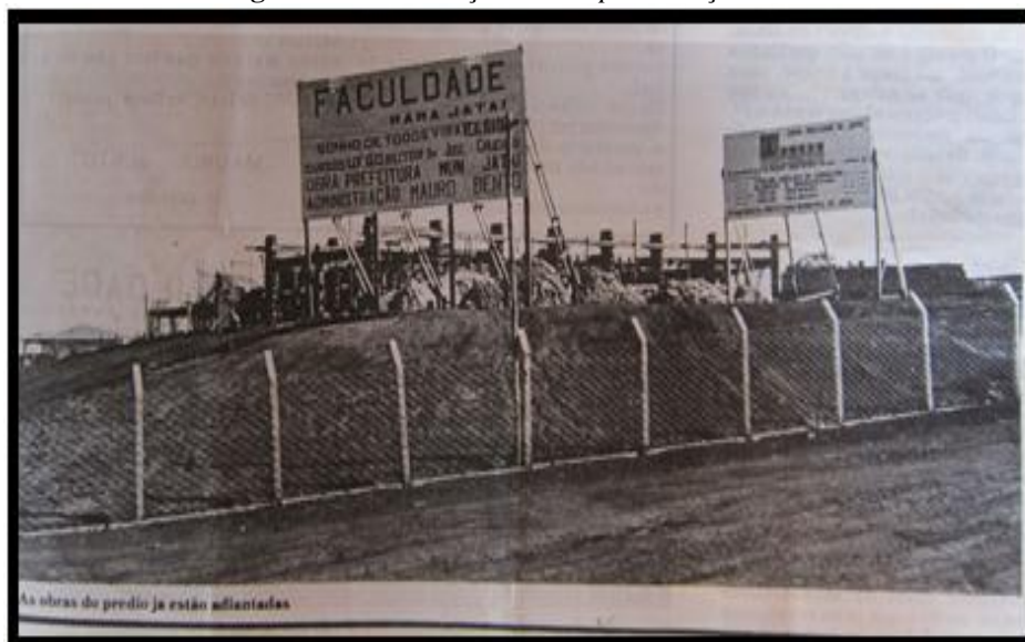
Fotografia 9 - Construção do campus avançado de Jataí
