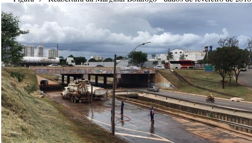
Figura 7– Reabertura da Marginal Botafogo - dados de fevereiro de 2018
