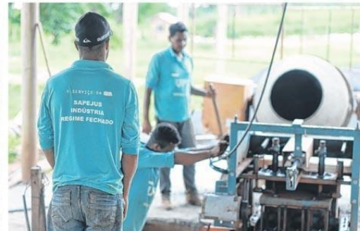
Uma das principais atividades desempenhadas no presídio é a linha de montagem de blocos de cimento, usados nas construções do próprio presídio
