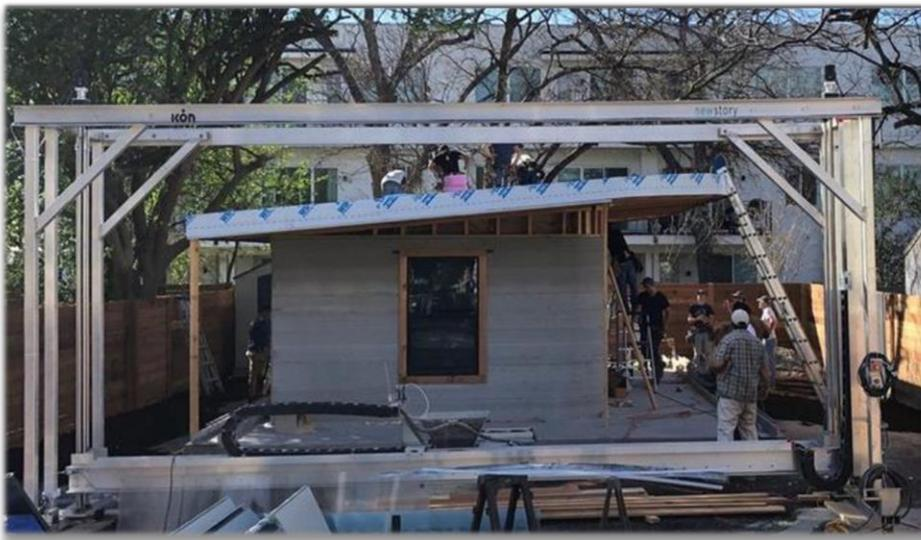
Figura 4 - Casa construída em Manufatura Aditiva
