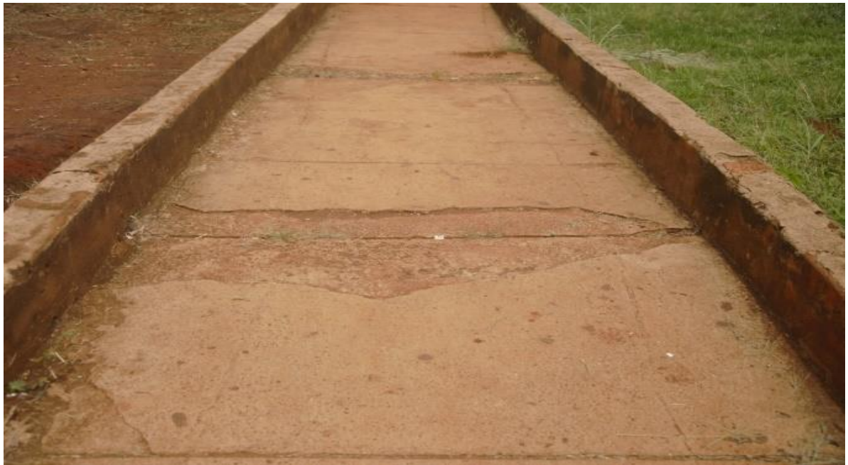
Figura 15 – Pátio CEPI – João Roberto Moreira – Acesso à quadra de esporte
