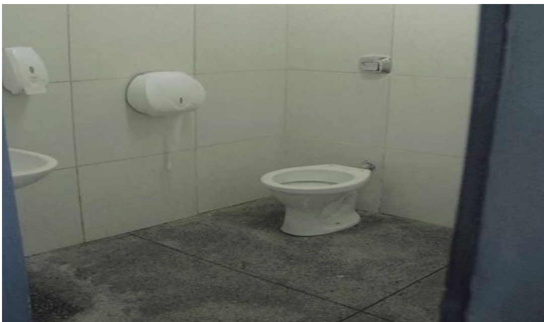
Figura 36 – Colégio Estadual Marcondes de Godoy / Sanitário PcD
