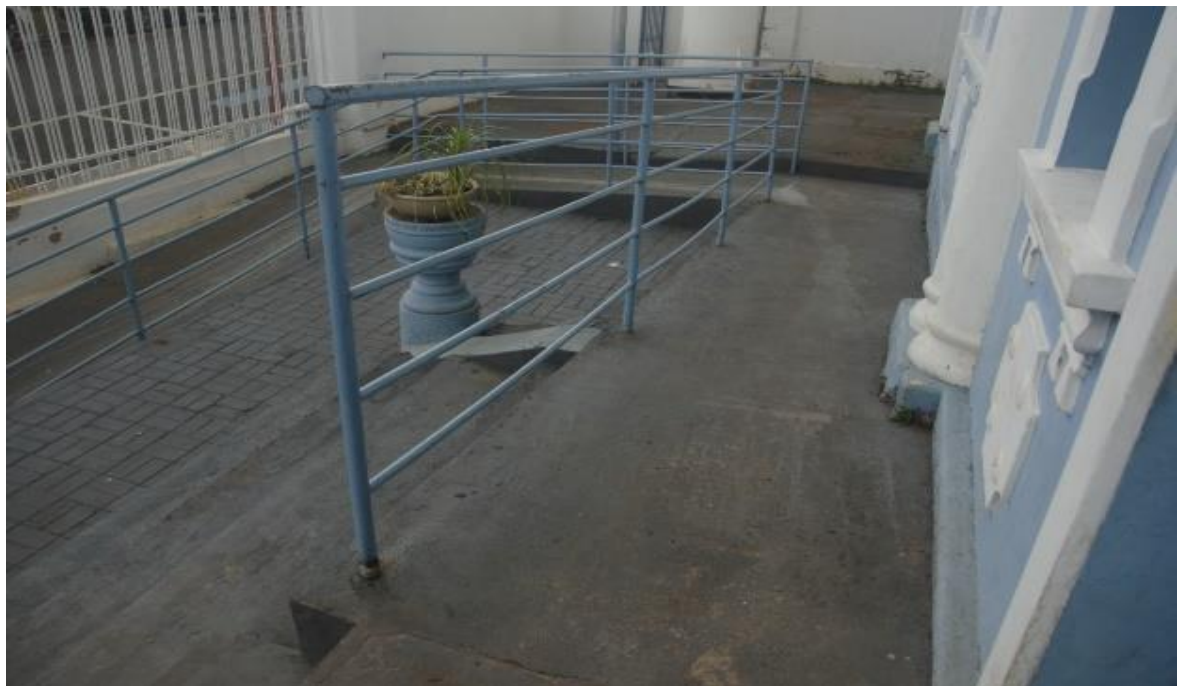
Figura 20 – Colégio Estadual Marcondes de Godoy – Rampa de acesso à entrada da Escola
