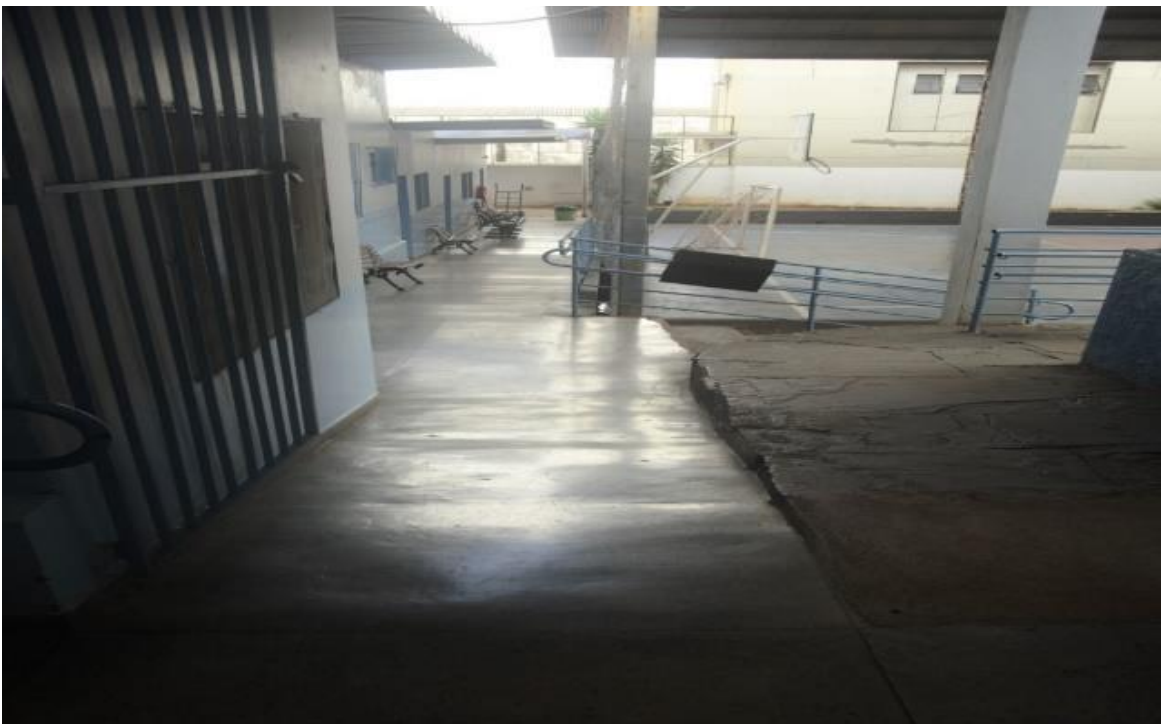
Figura 22 – Colégio Estadual Marcondes de Godoy – Rampa de acesso à quadra de esportes
