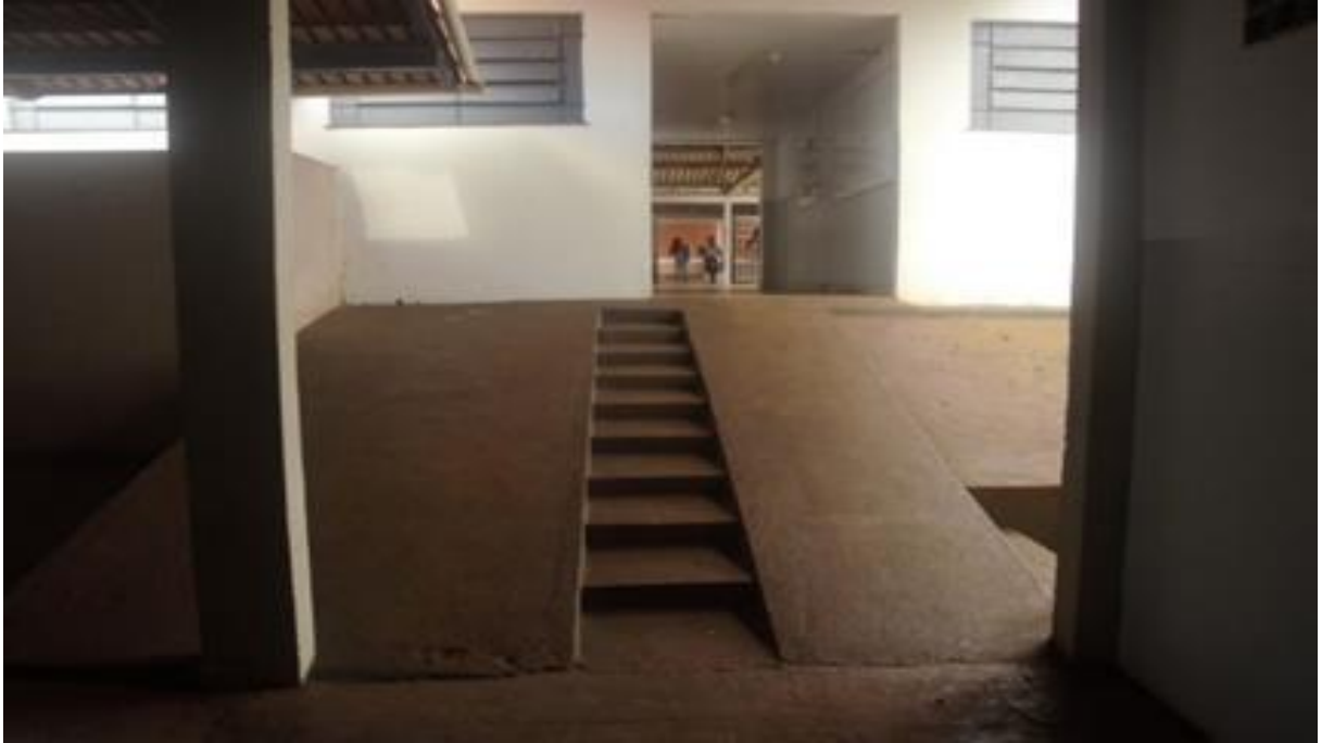
Figura 11 – Pátio CEPI – João Roberto Moreira – Rampa de acesso ao pátio coberto, à cozinha e ao refeitório
