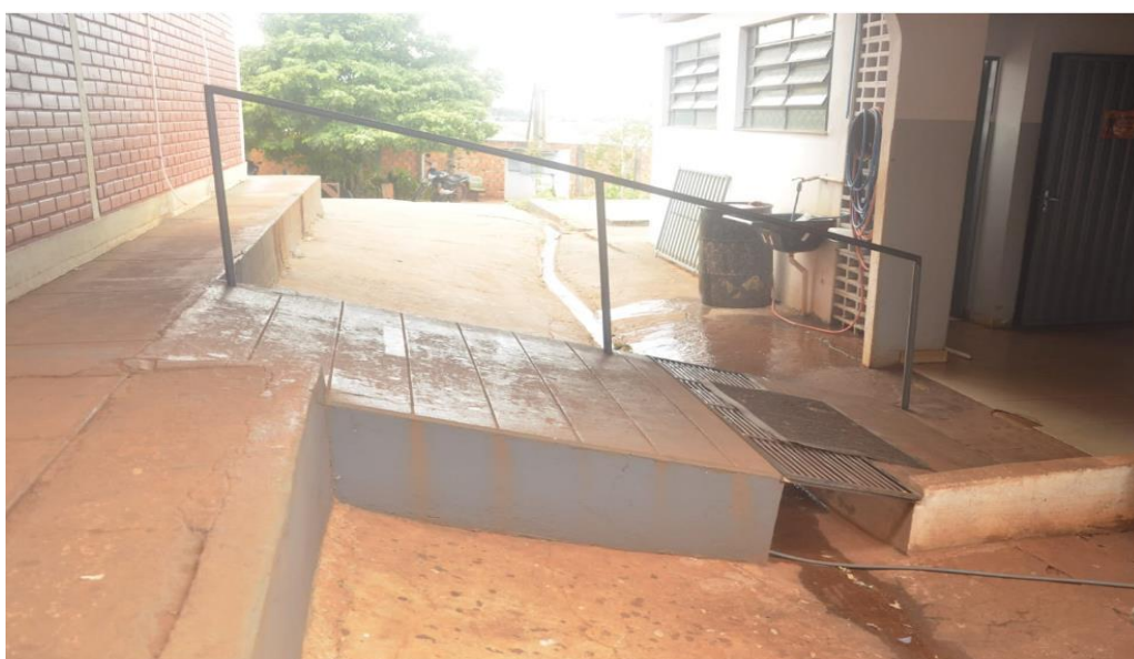
Figura 31 – CEPI – João Roberto Moreira – Rampa de acesso às salas de aula
