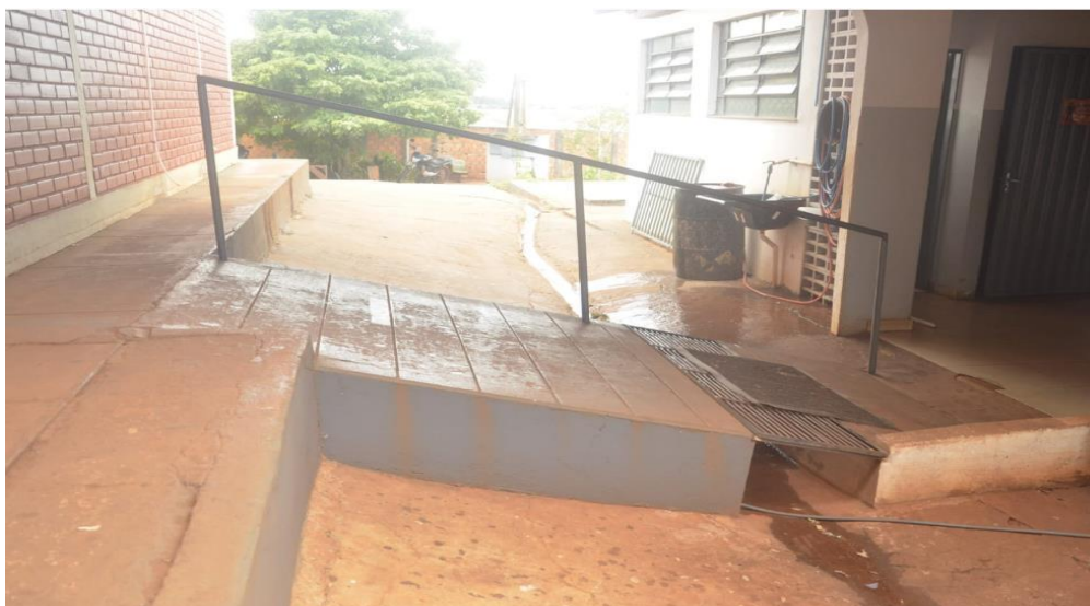
Figura 4 – CEPI – João Roberto Moreira – Rampa de acesso às salas de aula
