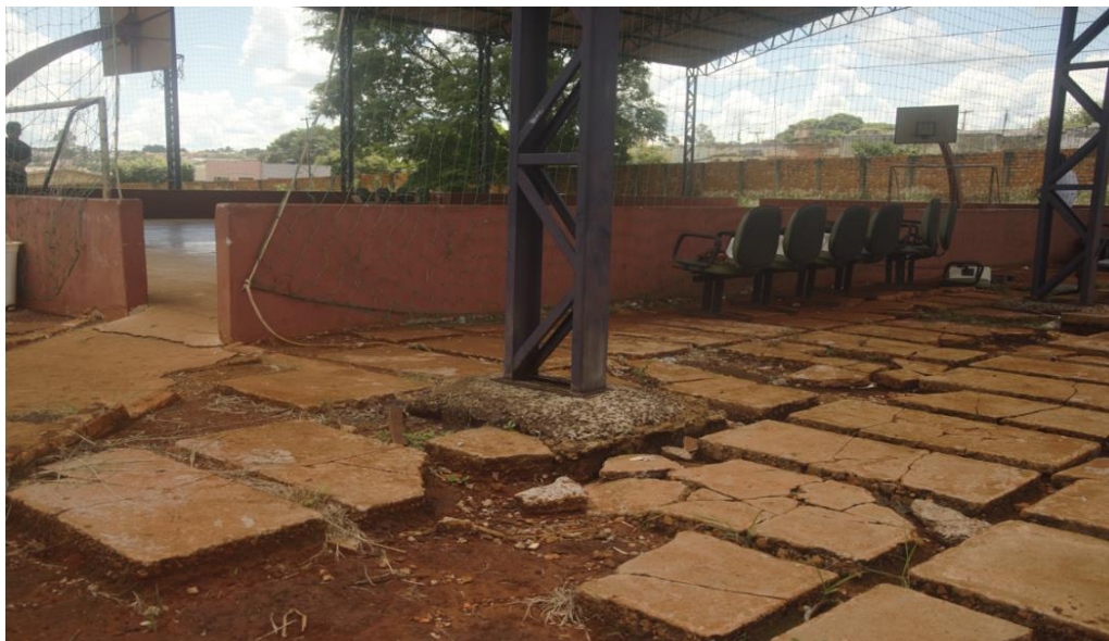
Figura 5 – Pátio CEPI – João Roberto Moreira – Acesso à quadra de esporte
