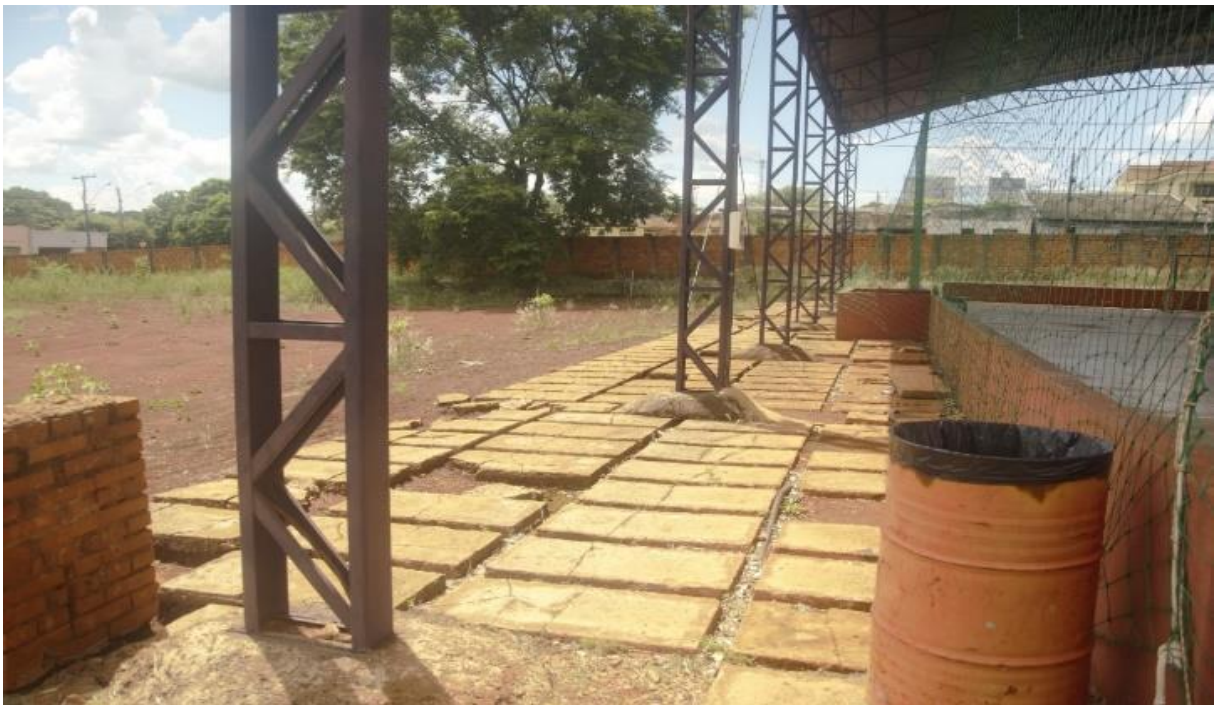
Figura 18 – Pátio CEPI – João Roberto Moreira – Acesso à quadra de esportes
