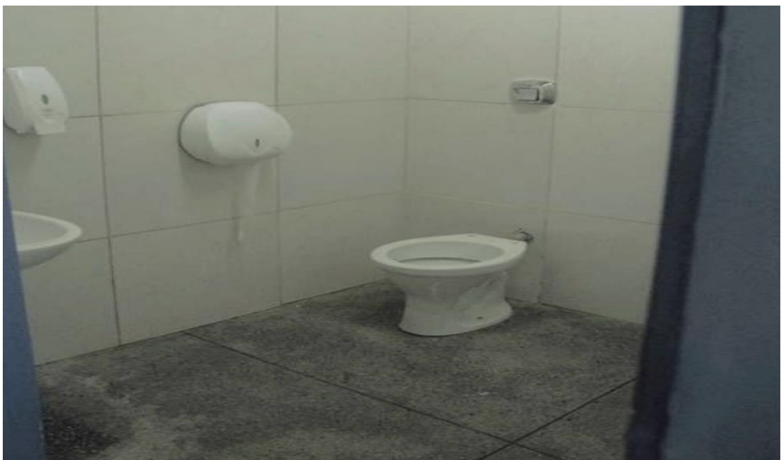
Figura 24 – Colégio Estadual Marcondes de Godoy – Sanitário – PcD
