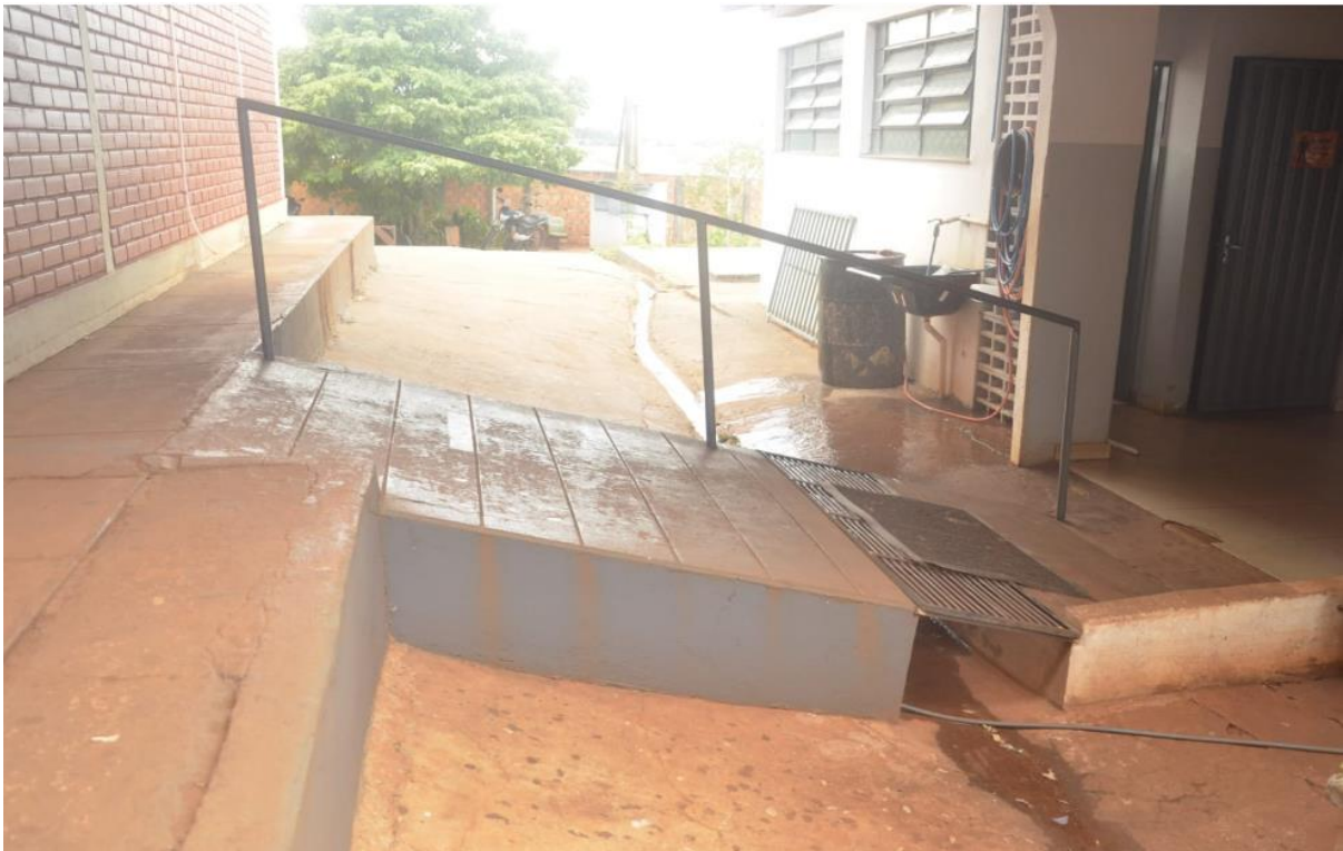
Figura 10 – CEPI – João Roberto Moreira – Rampa de acesso a salas de aula
