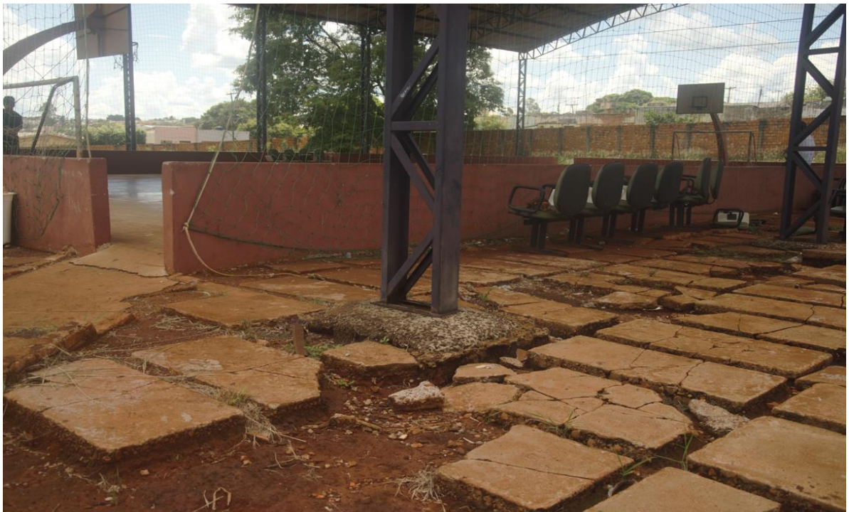
Figura 16 – Pátio CEPI – João Roberto Moreira – Acesso à quadra de esporte
