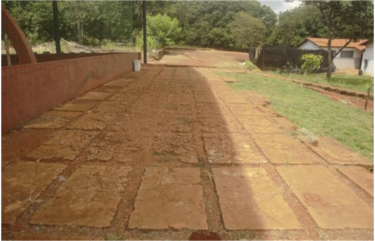
Figura 17 – Pátio CEPI – João Roberto Moreira – Acesso à quadra de esportes
