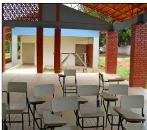
Foto 11. Espaço Coberto – Catalão/GO
