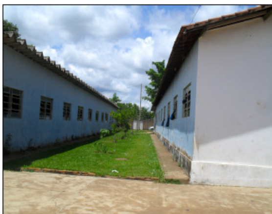
Foto 19. Pavilhão de Salas de Aula
