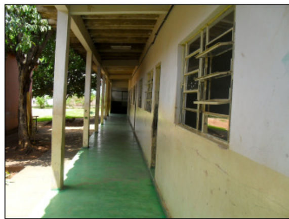
Foto 18. Pavilhão de Salas de Aula
