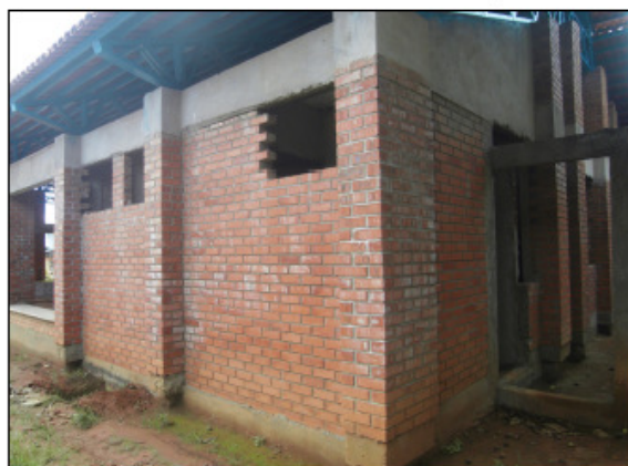
Foto 31. Banheiros em Construção
