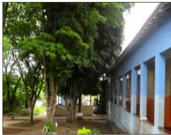
Foto 16. Pavilhão de Salas de Aula
