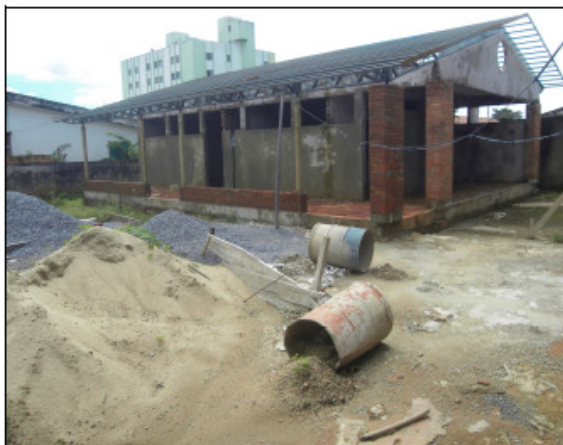
Foto 29. Vestiários (obra inacabada)
