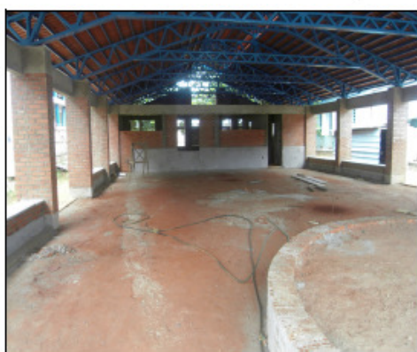
Foto 27. Refeitório em Construção
