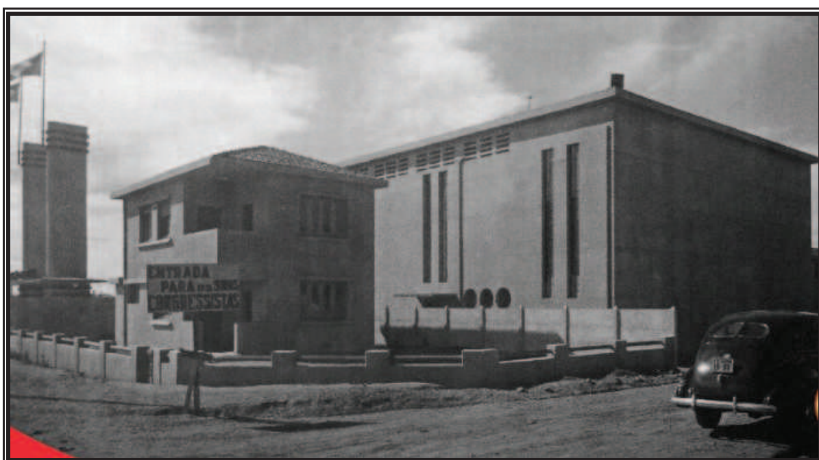
Foto 8 - Teatro e Pórtico do Câmpus Goiânia do IFG (1942)
